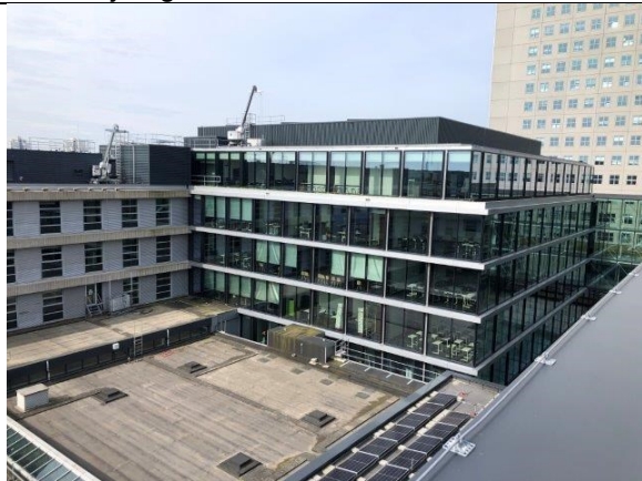
Gebouwdeel D, gezien vanaf gebouwdeel C.
