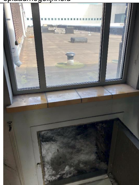
Cellulose isolatie onder houten dak
