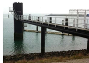
Figuur 7 Peilmeetstation in Noordland binnenhaven (pos. 10 Figuur 4) inclusief loopbrug en trappen. Opmerking: afbeelding is niet op schaal en slechts ter illustratie
