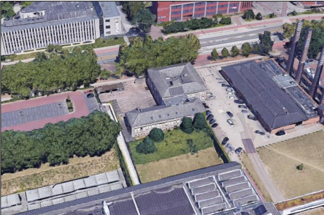
Afbeelding 2.1 | Gebouw M835 (in het midden) met daaronder de binnentuin waar de nieuwbouw wordt gerealiseerd.
