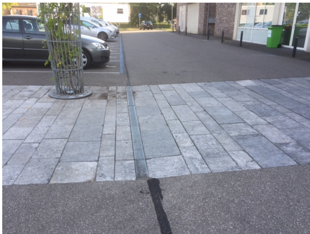
Voorbeeld “Lijngoot”; reinigen per meter (Locatie parkeerterrein Houtlaan te Groesbeek) Bestekpostnr. 121010
