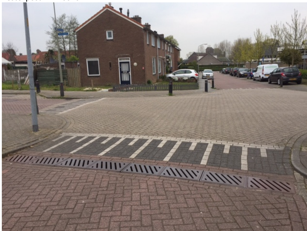
Voorbeeld “gekoppelde” kolken; reinigen per stuk (Locatie: Eikstraat te Breedeweg) Bestekpostnr. 110010
