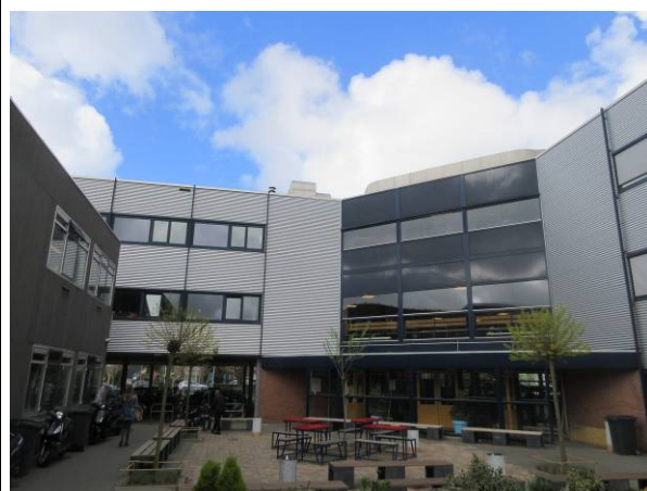
Aanzicht gebouwgevels vanaf het (binnen)plein
