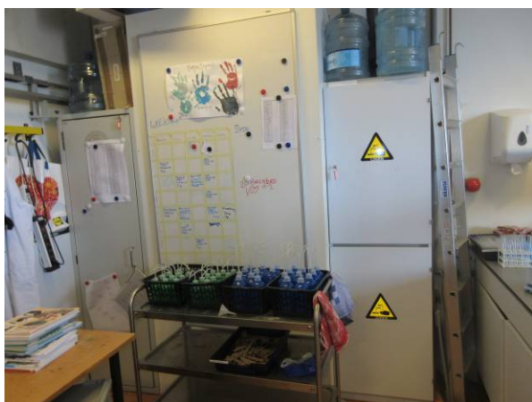
Achterzijde zuurkast en opslag brandbare vloeistoffen en zuren/logen
