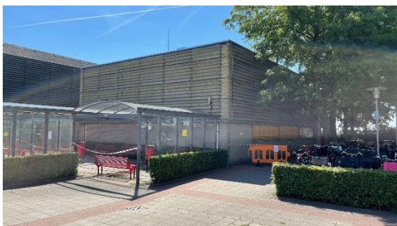
Gymzaal noordzijde, vanaf schoolplein RSG
