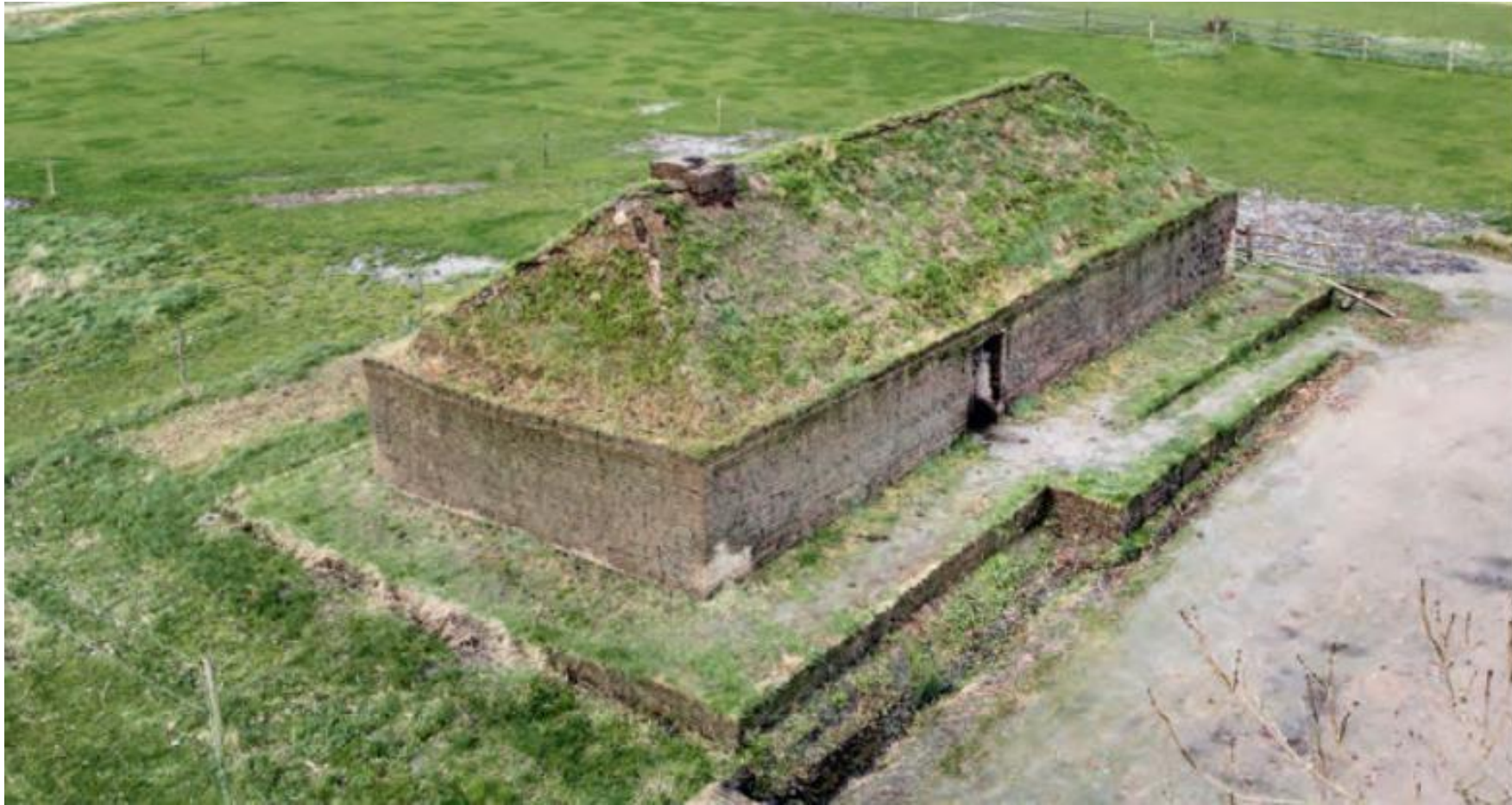
Wiederaufbau eines Grassodenhauses, Firdgum (Friesland)
