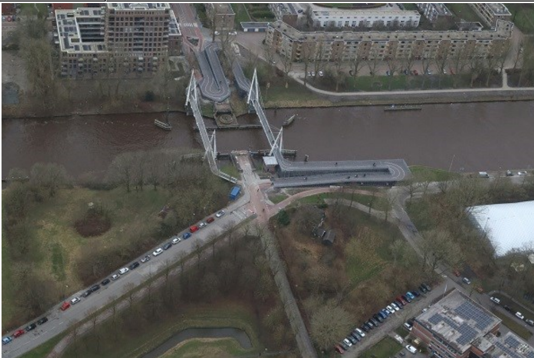
Bestaande Bruggen met tijdelijke hellingbanen westelijke fiets-/loopbrug – luchtfoto RWS
