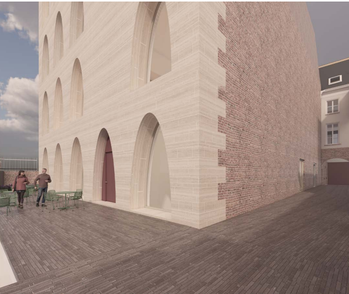
Vertande overgang binnenpleingevel naar steeggevel
