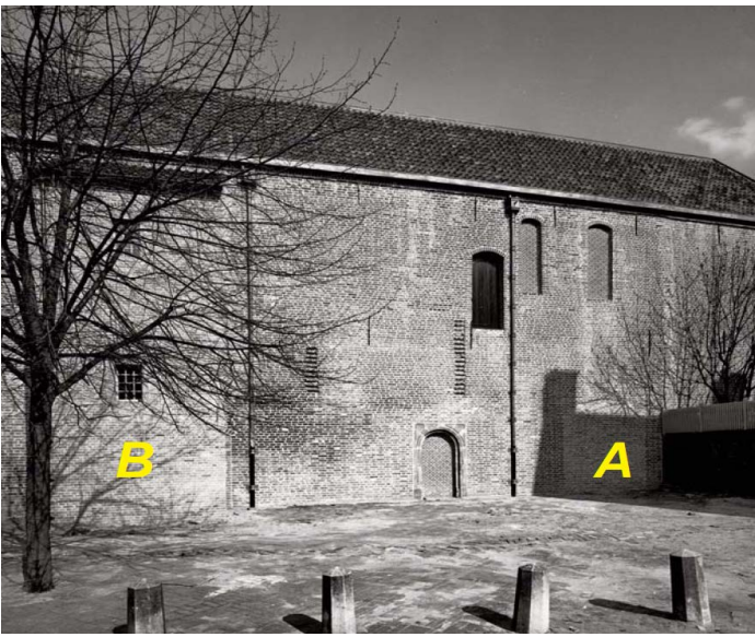
Poort naar het pandhof (A) gesloten in 1979 (Emmens 2020)
