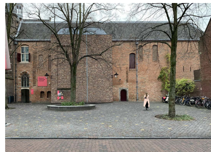
Westgevel aan het voorplein (2021)
