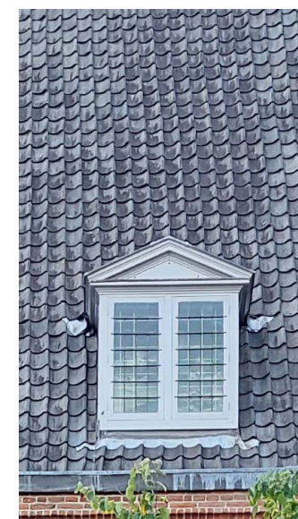
Twee typen dakkapellen die zullen worden opgetild en herplaatst
