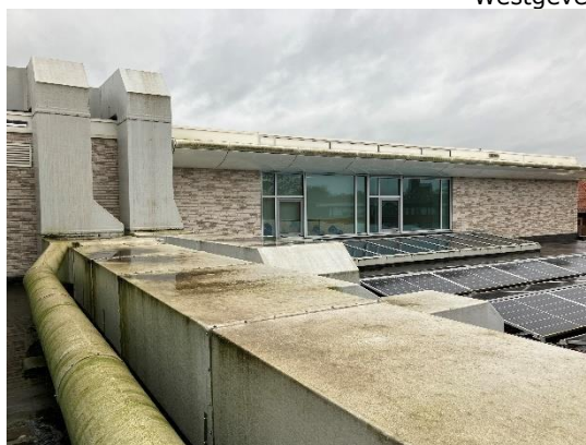
Daken met installaties
