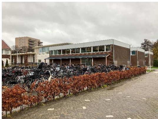
Noordgevel met fietsenstalling
