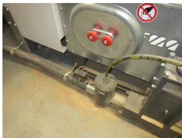
Aanzicht briketpers in gebouw 2
