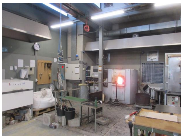
Inkijk glasblazerij gebouw 1 aanbouw
