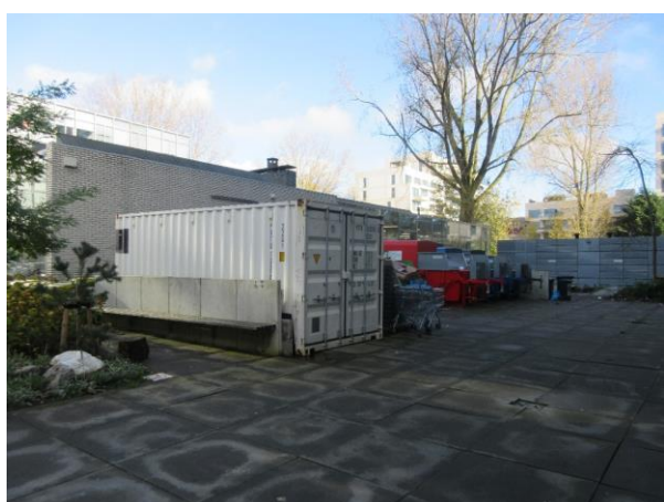
Aanzicht vuilopslag tussen gebouwen 1 en 2
