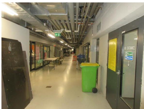
Inkijk gang gebouw 1
