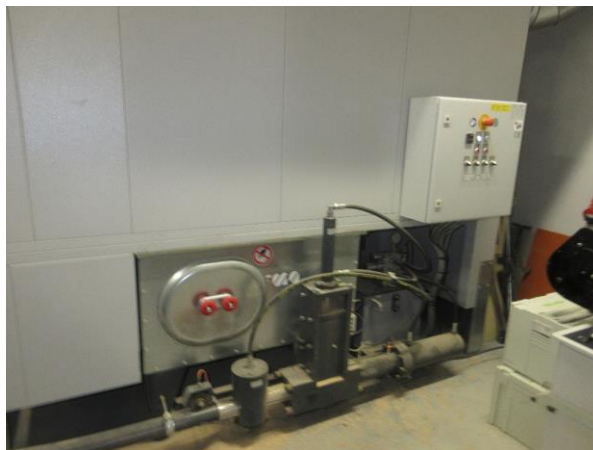
Aanzicht motfilterkast met briquetpers
