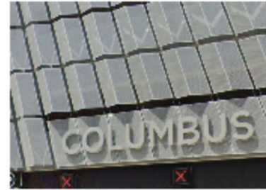
Eén paneel vervaardigd uit één gevouwen metaal plaat. In het geval van MFKL is de horizontale naad tussen de panelen minimaal.
