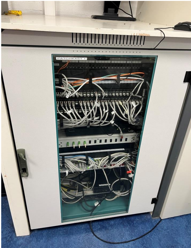
Inhoud patchkast (huurder) Recorder beveiligingscamers's (gemeente)
