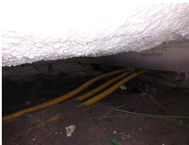
Tegen de onderzijde van de vloer is purschuim aangebracht
