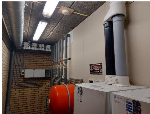
De cv-ruimte is na 2012 verbouwd.
