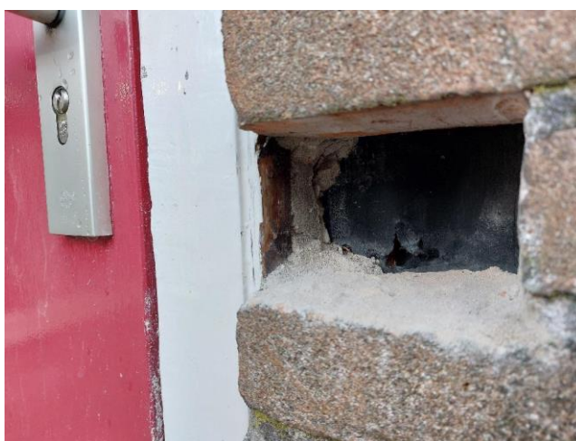
Naast de bergingsdeuren is in de spouw een kunststof flap aangebracht
