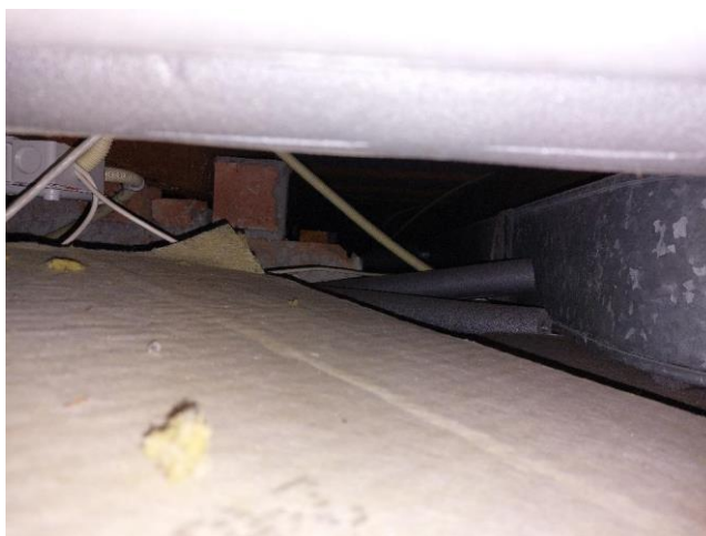
Situatie boven het gipsplafond in de leermiddelenberging
