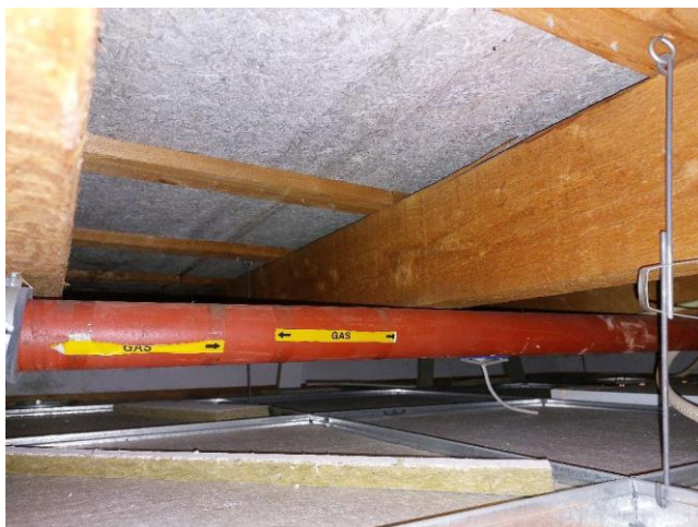
Het dak is voorzien van houtwolcementplaten
