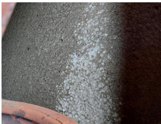
Onder de dakpannen is op de steile delen piepschuim toegepast
