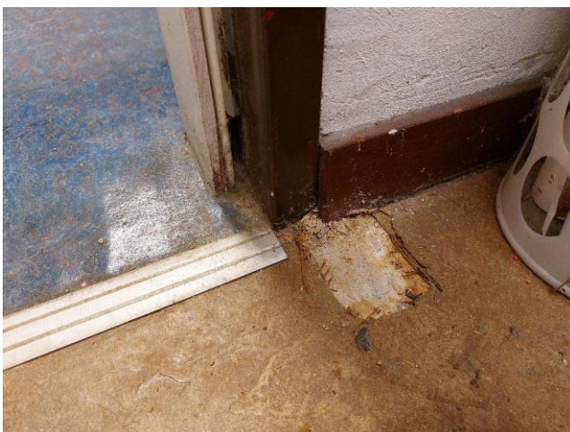
Het linoleum is gelijmd op beton
