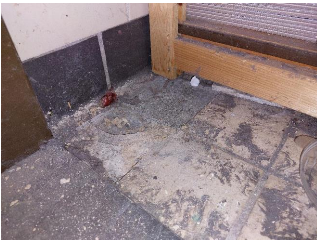
Vloertegels zijn gezet in specie en stofdorpels zijn van natuursteen
