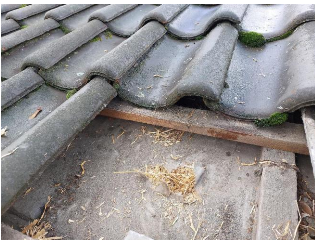
Onder de dakpannen zijn stroplaten toegepast
