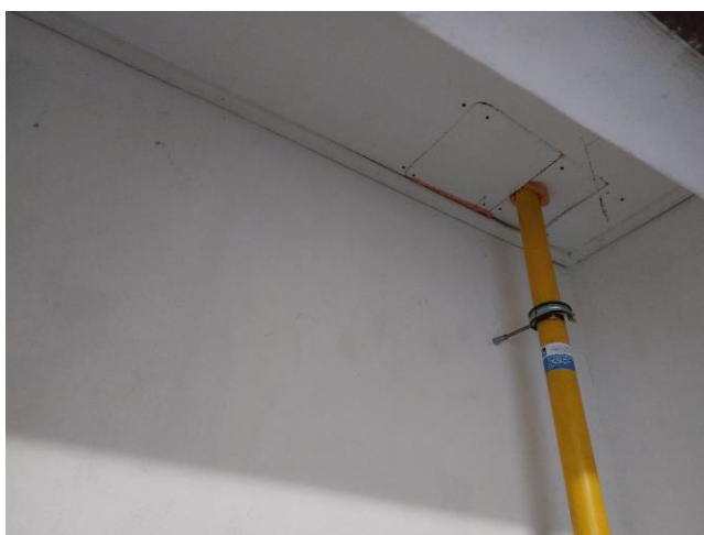
Het plafond van de gasmeterruimte is van gips
