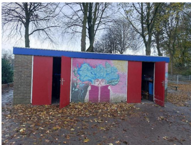
De buitenberging is halfsteens gemetseld en heeft in pandig metalen hemelwaterafvoer. op de vloer liggen tegels.
