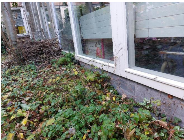
T.p.v. de kleine patio zijn een aantal kozijnen op betonnen elementen geplaatst.
