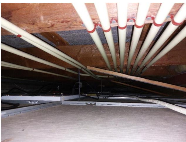
Zicht boven het verlaagde plafond in de gang
