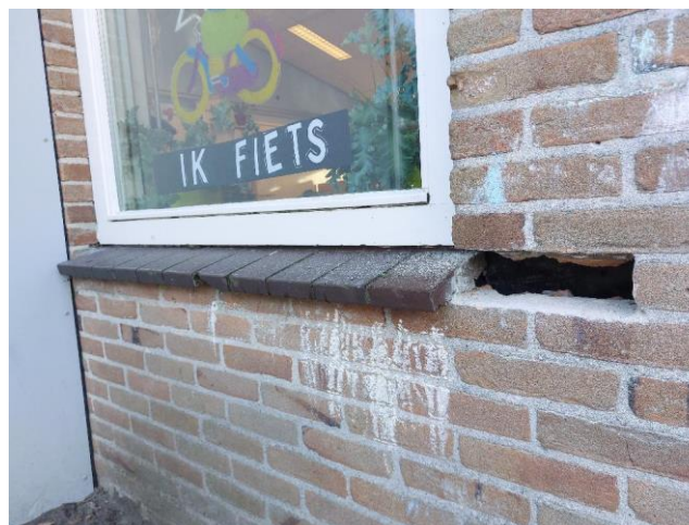
In de spouw t.p.v. een enkel kozijn is een kunststof flap aangebracht
