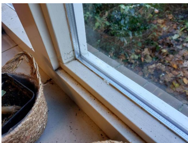
Het dubbelglas in de buitengevel is gekit met onverdachte kit
