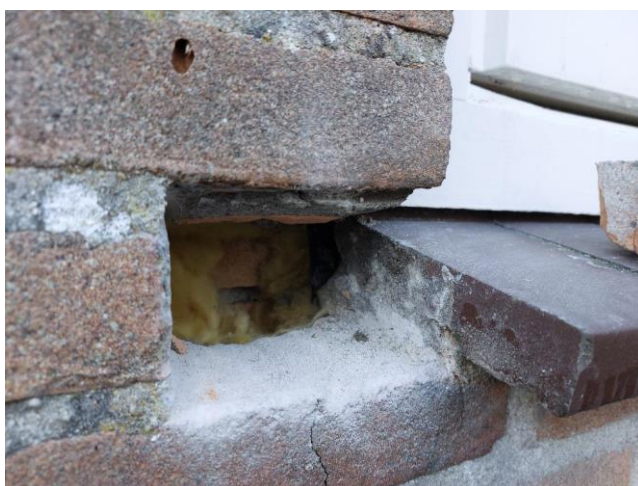
In de spouw t.p.v. een enkel kozijn is een kunststof flap toegepast
