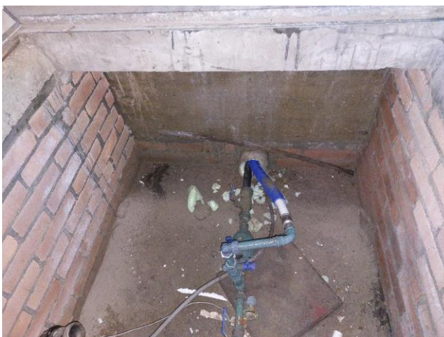
T.p.v. de watermeter is een pvc mantelbuis toegepast.
