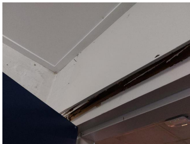
Achter de houten bovenlichten bevindt zich glaswolisolatie.
