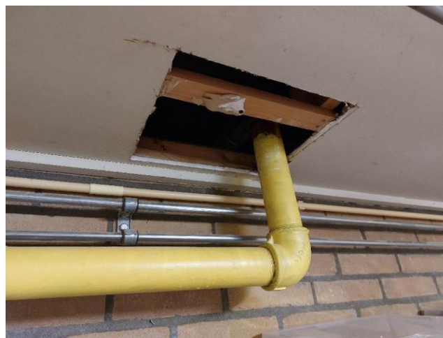
Boven het gipsplafond in de berging zijn geen verdachte materialen waargenomen
