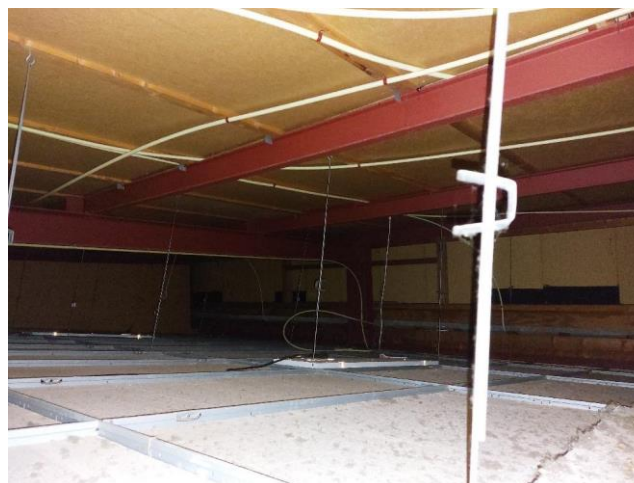
Zicht boven het verlaagde plafond in het BSO lokaal
