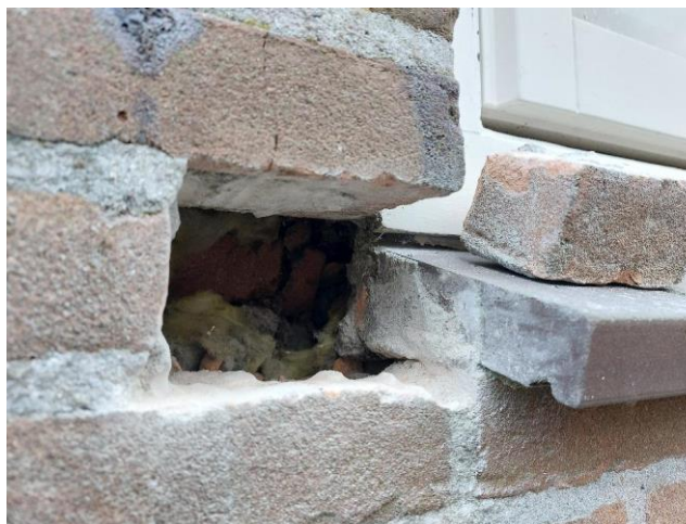
In de spouw is alleen glaswolisolatie waargenomen
