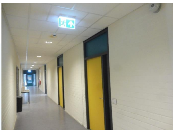
Gebouw 1: inkijk in een van de gangen.
