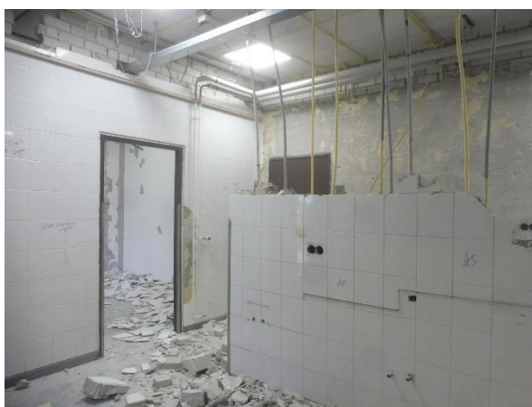
Gebouw 1: keuken onder constructie.
