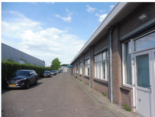
Zuidgevel, gezien vanaf het terrein.
