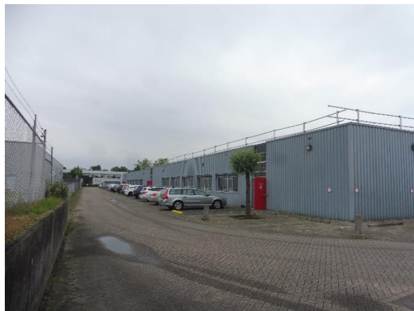
Zicht op de zuidelijke gebouwgevel, gezien vanaf het achterterrein.
