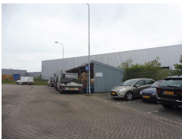
Gebouw 3: gezien vanaf het terrein.
