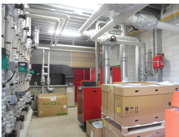
Inkijk in de stookruimte met tijdelijke opslag in verband met de dakdekkerswerkzaamheden.
