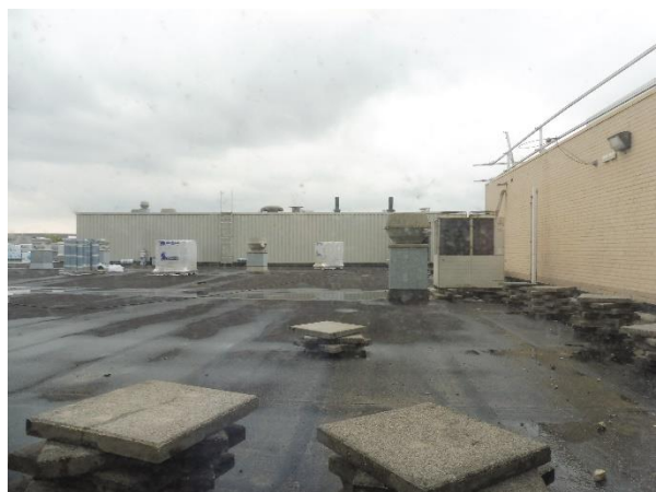
Inkijk op een dakgedeelten.
