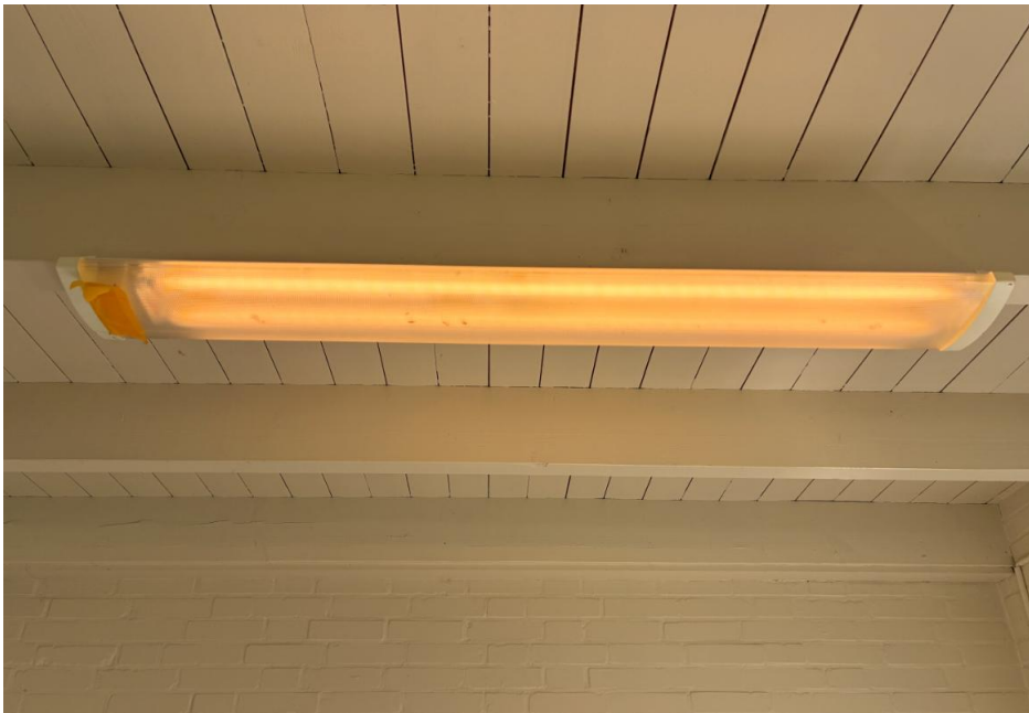
Foto 72: Detailfoto van armatuur in schaftlokaal Dienstgebouw begraafplaats Waspik
