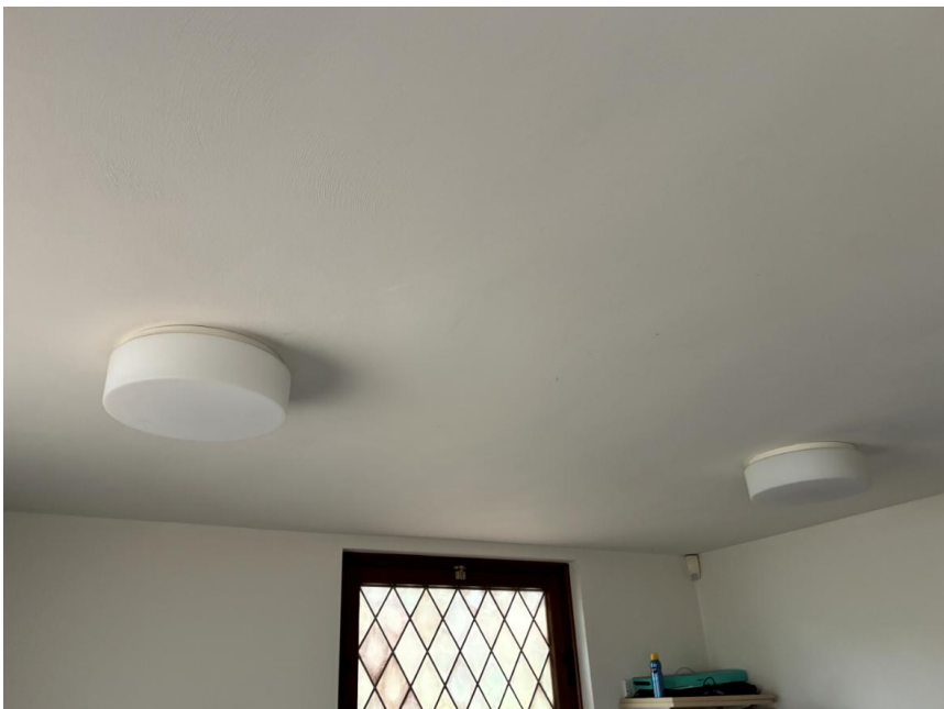
Foto 62: Overzichtsfoto armaturen in kantineruimte Aula begraafplaats Sprang
