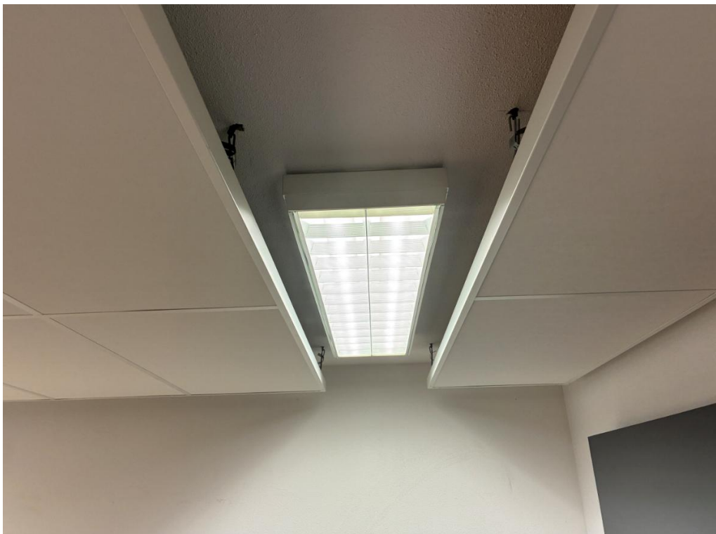
Foto 45: Foto van opbouw TI-armaturen in verblijfsruimtes Brandweerpost Sprang-Capelle
