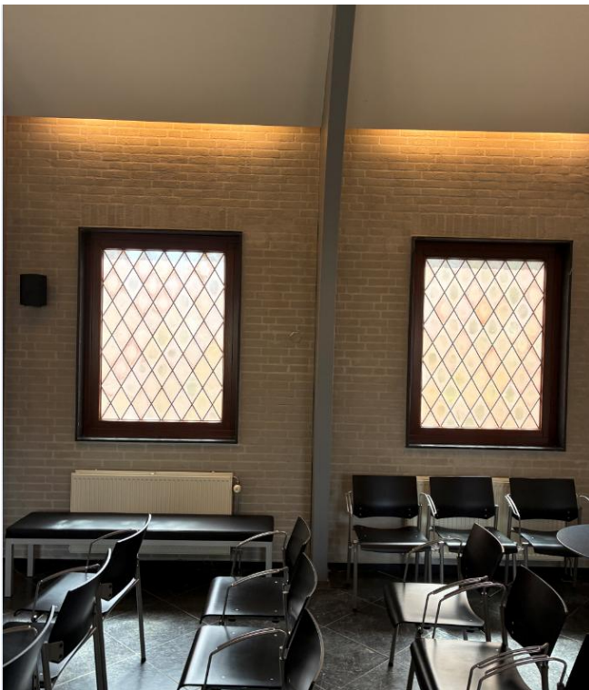
Foto 58: Overzichtsfoto 2 van armaturen boven verlaagd plafond Aula begraafplaats Sprang
