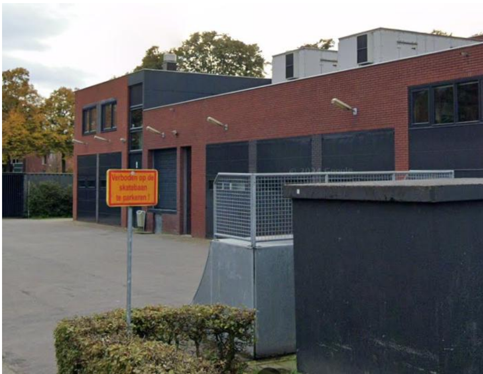
Foto 24: Gevelarmaturen aan oostzijde Tavenu
