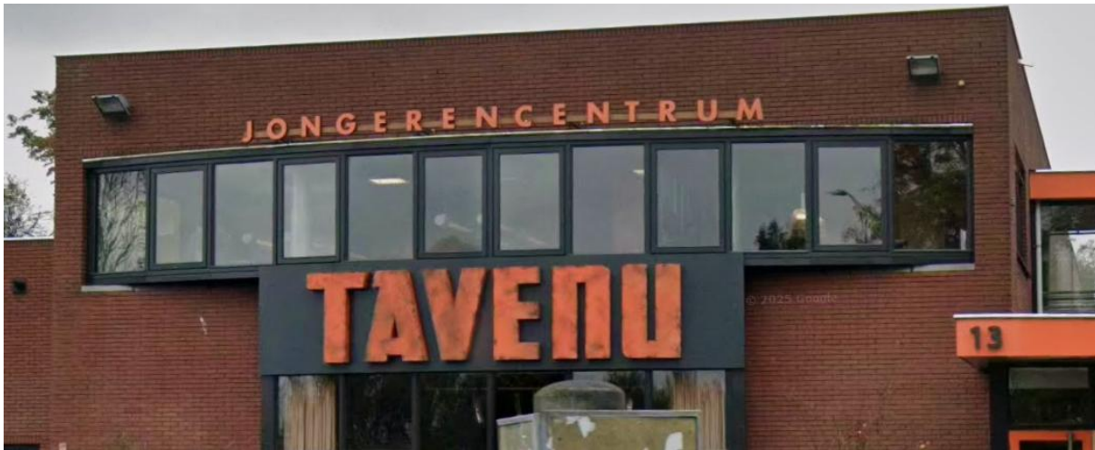
Foto 22: Gevelarmaturen aan voorzijde Tavenu
