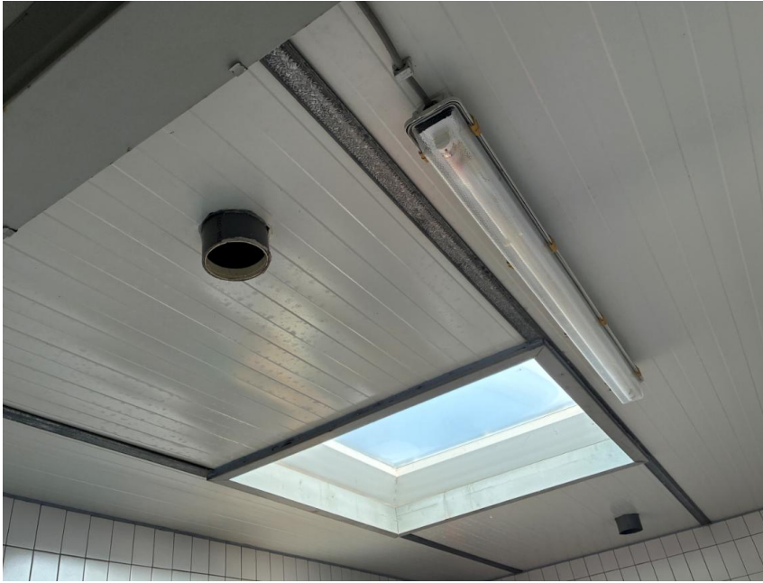
Foto 82: Overzichtsfoto plafond toiletten en kleedruimtes Openluchtwembad Zidewinde
