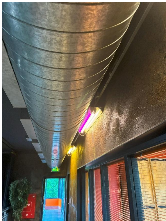
Foto 18: Overzichtsfoto armaturen op balkon 1e verdieping Tavenu
