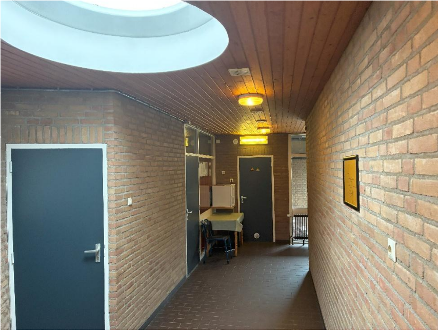
Foto 1: Overzichtsfoto verlichting gangzone Gymzaal Wijnruitstraat
