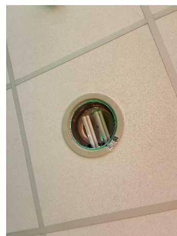
Foto 34: Detailfoto van armaturen in gangzone
