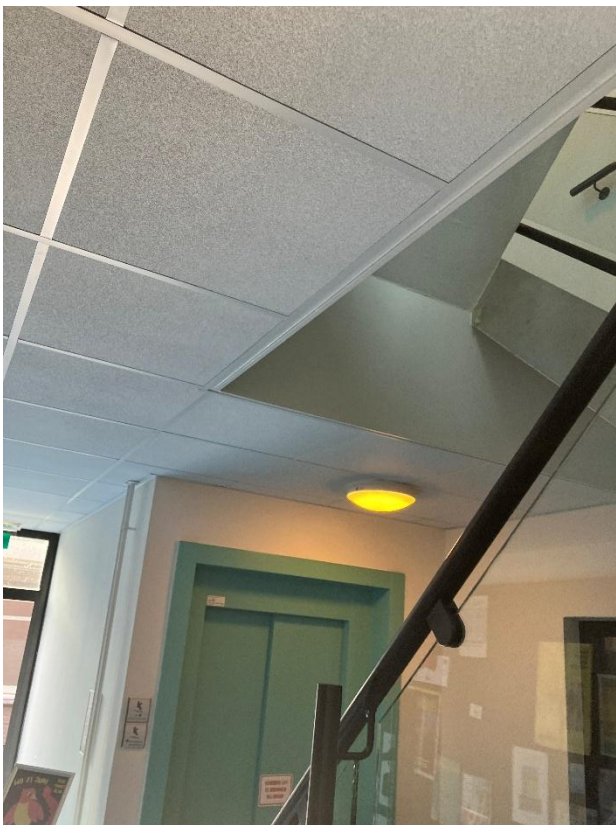
Foto 33: Voorbeeld PL-verlichting in gangzone verdieping Kunstencentrum
