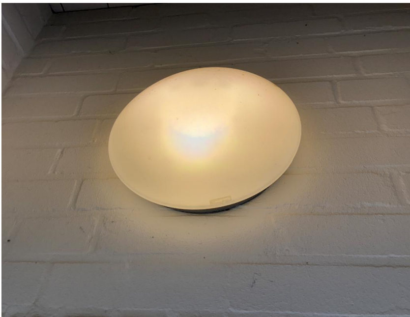
Foto 73: Detailfoto armatuur in entree Dienstgebouw begraafplaats Waspik
