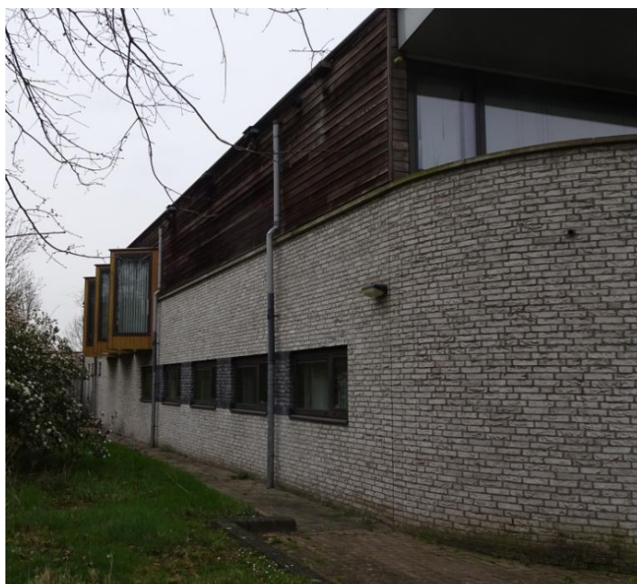
Foto 50: Overzichtsfoto van wandarmatuur buiten Brandweerpost Sprang-Capelle
