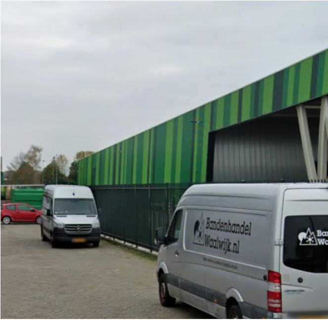
Foto 41: Overzichtfoto gevelarmaturen Gemeentewerf Waalwijk
