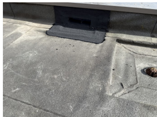
Lage dak rechts noodoverstort opnieuw ingewerkt
