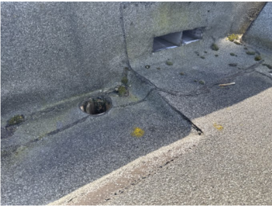
Hoge dak rechts achter hwa en noodoverstort
