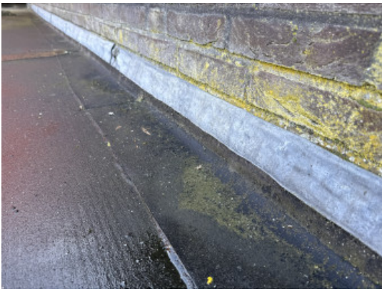
Lage dak rechts achter opgaand werk en loodslab
