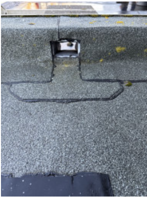
Lage dak rechts achter noodoverstort
