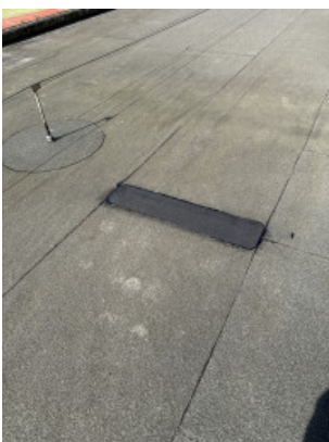
Lage dak links achter naad afgedicht met strook
