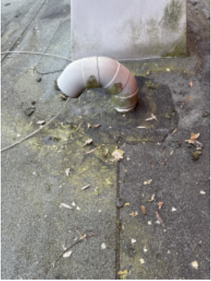
Lage dak rechts kabel doorvoer
