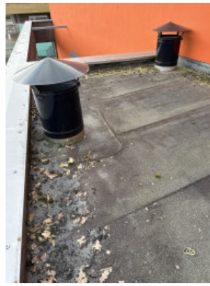
Lage dak links voor beluchtungskappen
