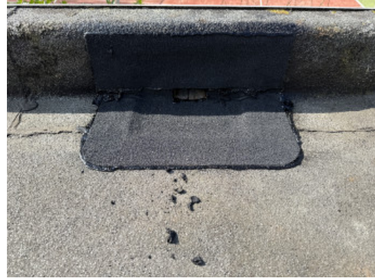
Lage dak links achter hwa opnieuw ingewerkt
