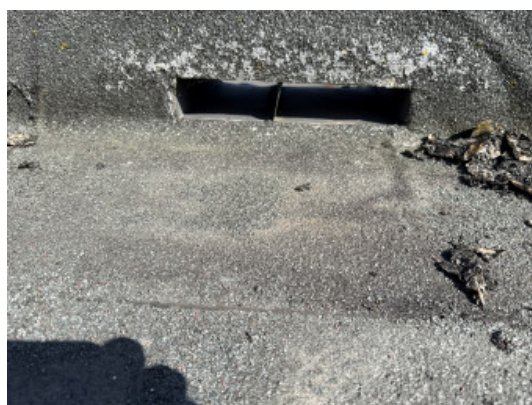
Hoge dak links achter noodoverstort
