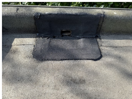
Lage dak links achter hwa opnieuw ingewerkt
