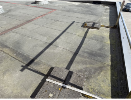
Lage dak rechts voor schoon
