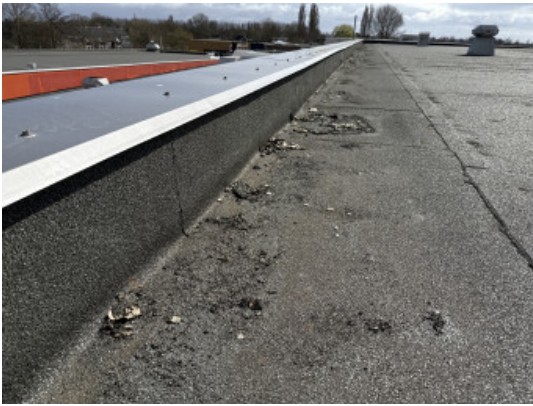
Hoge dak links achter randafwerking en opgaand werk
