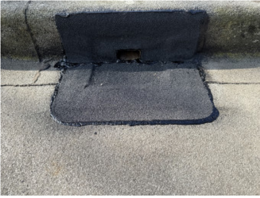
Lage dak links achter hwa opnieuw ingewerkt
