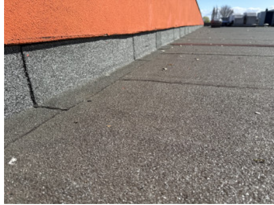
Hoge tussendak opgaand werk
