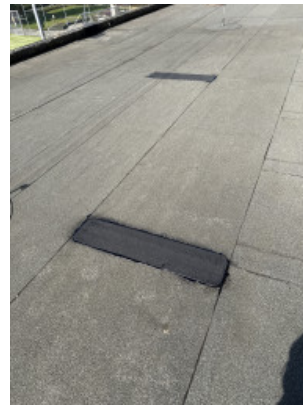
Lage dak links achter twee naden dichtgemaakt met nieuwe strook
