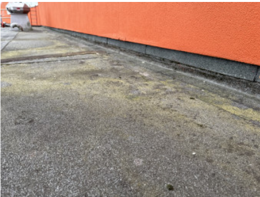
Lage dak rechts voor opgaand werk
