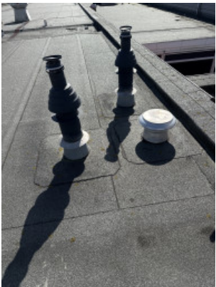
Hoge dak voor rga's en ontluchting
