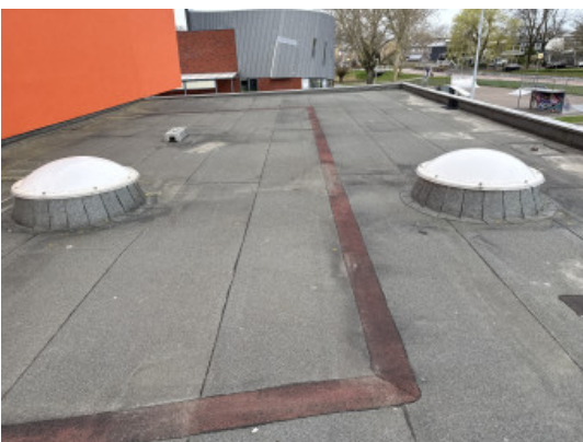
Lage dak rechts voor schoon
