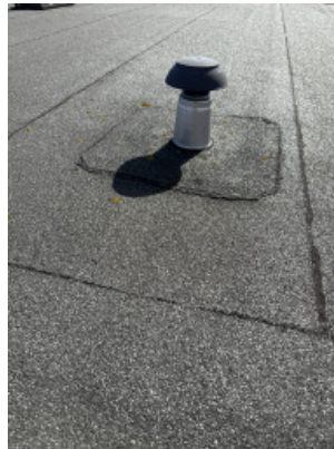
Hoge dak voor ontluchting
