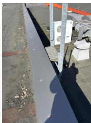
Hoge dak links achter gevelladder
