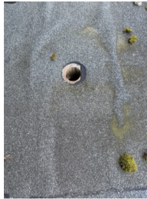
Lage dak rechts achter hwa
