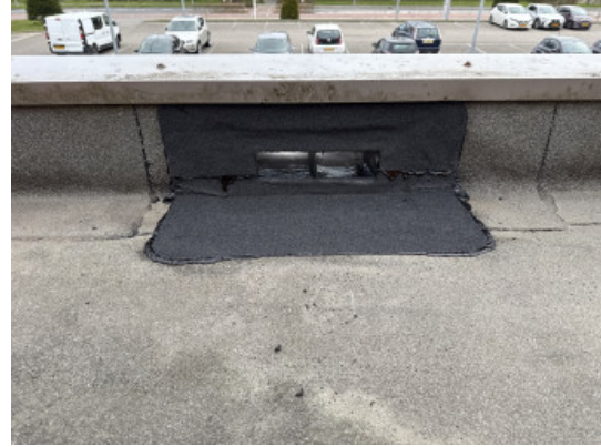
Lage dak rechts voor noodoverstort opnieuw ingewerkt
