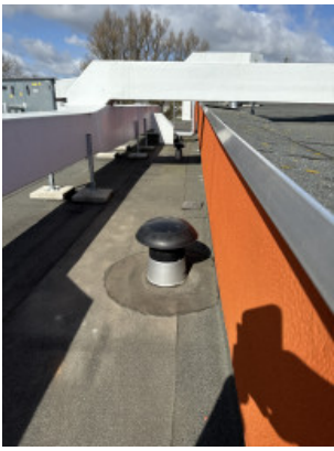
Hoge dak rechts achter ontluchtingen
