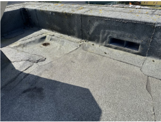
Hoge dak rechts achter hwa en noodoverstort
