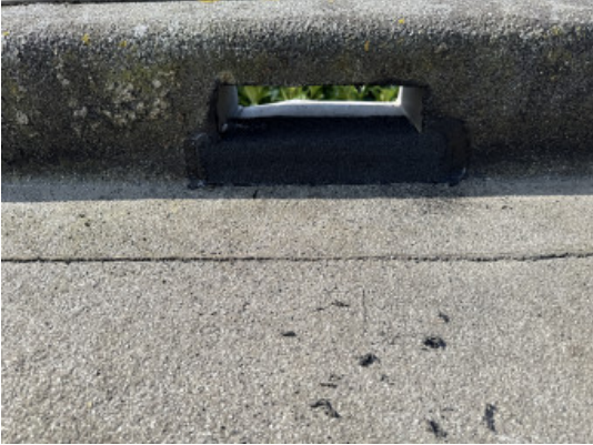
Lage dak achter links noodoverstort gerepareerd
