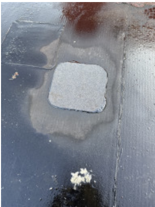
Lage dak rechts achter lekkage gerepareerd
