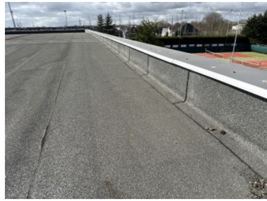
Hoge dak links achter randafwerking en opgaand werk
