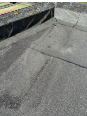
Hoge dak rechts achter blaas/ploovorming
