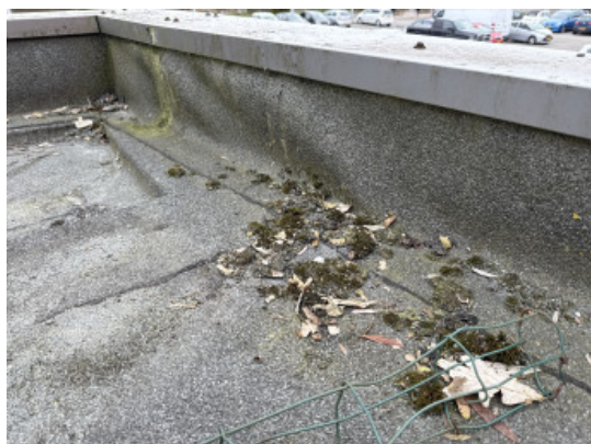
Lage dak rechts voor blaas/plooivorming
