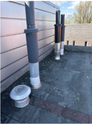
Hoge tussendak rga's en ontluchting
