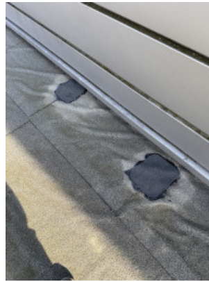
Lage dak links achter twee lekkages gerepareerd
