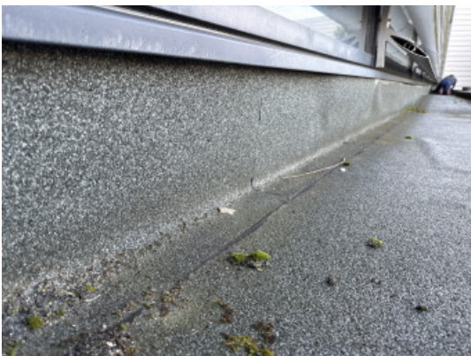
Lage dak rechts achter opgaand werk
