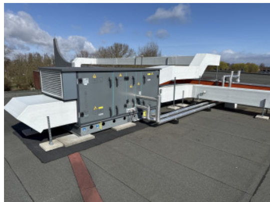
Hoge dak rechts achter luchtbehandeling
