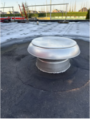
Lage dak rechts achter ontluchtingen
