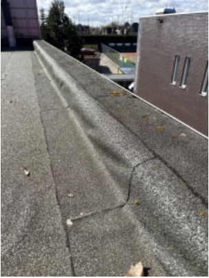
Hoge tussendak randafwerking en opgaand werk
