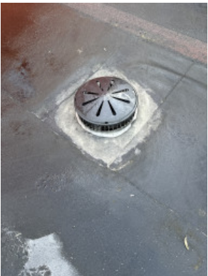
Lage dak rechts achter hwa
