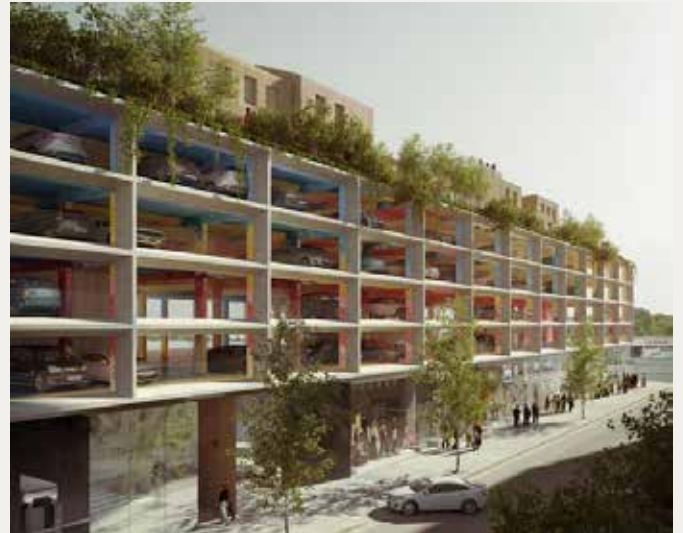
Natuurinclusief gebouw Bordeaux car park - Brisac Gonzalez
