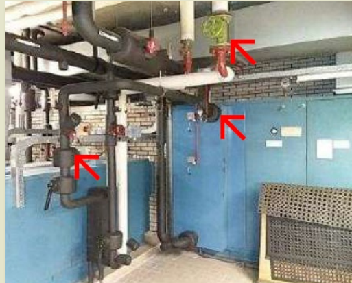
Foto: Voorbeeld van nog aanwezige flenspakkingen ruimte S.091.
