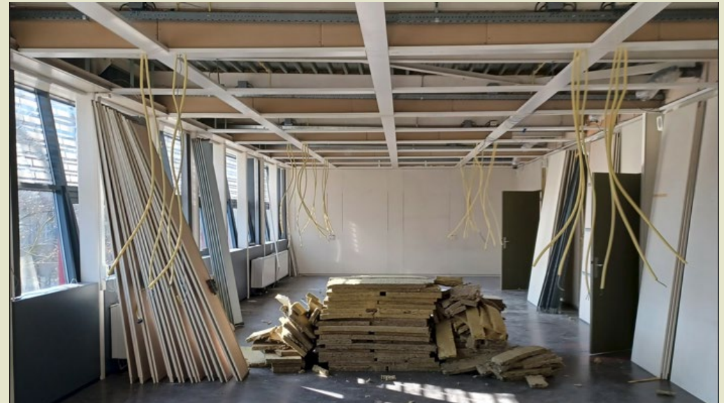
Foto: Systeemwanden, plafonds en verlichting van de kantooromgeving zijn gedemonteerd en inmiddels opgeslagen.
