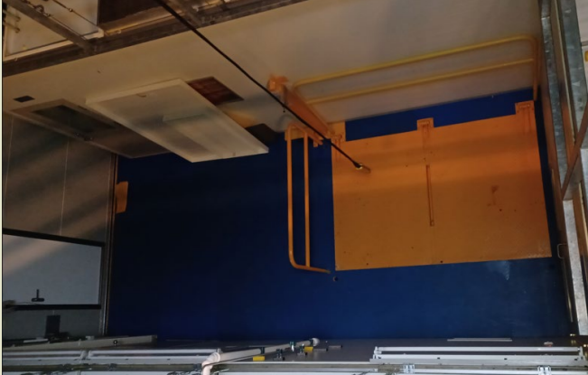
Foto: de hijsvoorziening bij de expeditie ingang (met hijsluik), van bovenaf gezien
