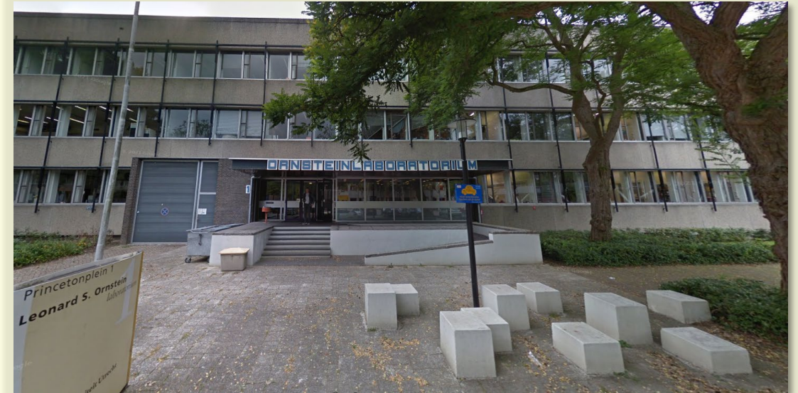
Foto: Het Ornsteingebouw met de huidige hoofdentree. Indien er een gezamenlijke entree komt, zal deze een nevenentree worden.
