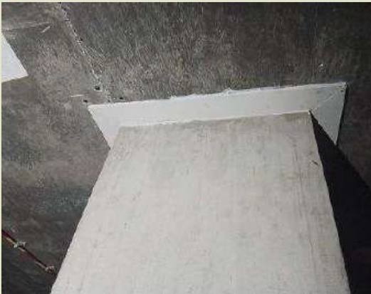
Foto: Stortstroken in souterrain zijn duurzaam afgeschermd.
