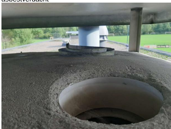
Kleedkamer 1, dak doorvoering pvc en metaal
