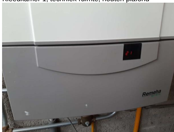
Kleedkamer 1, technische ruimte, cv installatie niet asbestverdacht
