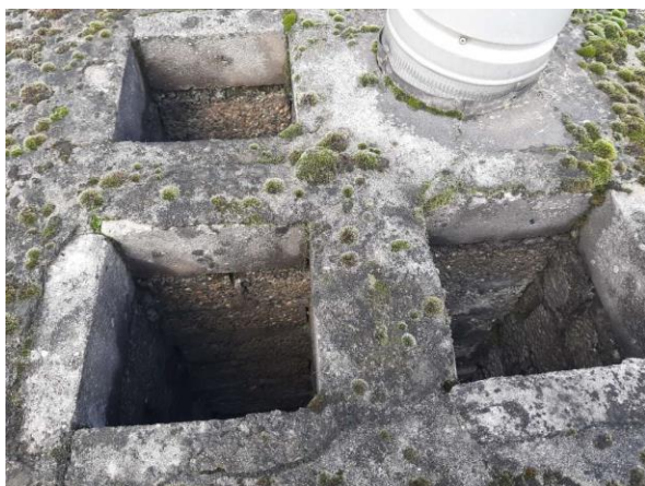
Kleedkamer 2, schoorsteen kanalen gemetseld
