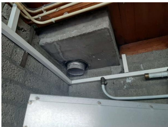
Kleedkamer 1, techniek ruimte, doorvoering metaal
