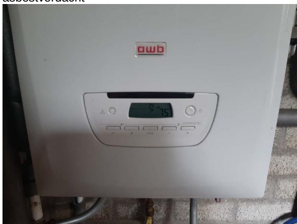
Kleedkamer 2, techniek ruimte 2, cv installatie niet asbestverdacht
