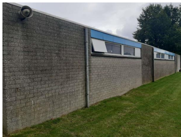
Kleedkamer 2, techniek zijgevel
