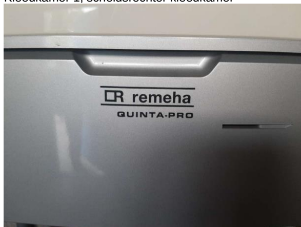
Kleedkamer 1, techniek ruimte cv installatie, niet asbestverdacht
