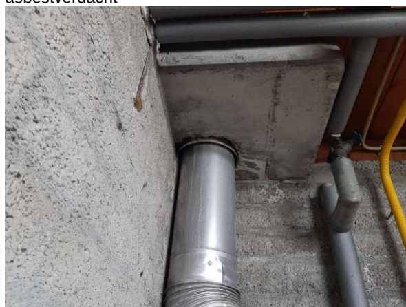
Kleedkamer 2, techniek ruimte doorvoering dak metaal
