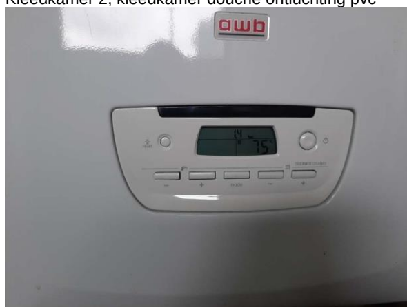
Kleedkamer 2, techniek ruimte, cv installatie niet asbestverdacht
