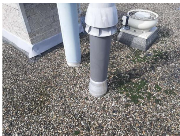
Kleedkamer 1, dak doorvoering pvc en metaal
