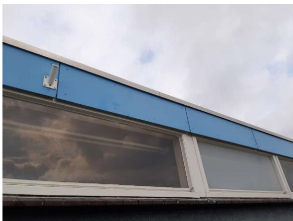
Kleedkamer 1, boeiboorden zijn van trespaa
