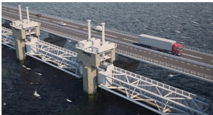
Figuur: Schuiven Oosterscheldekering.
