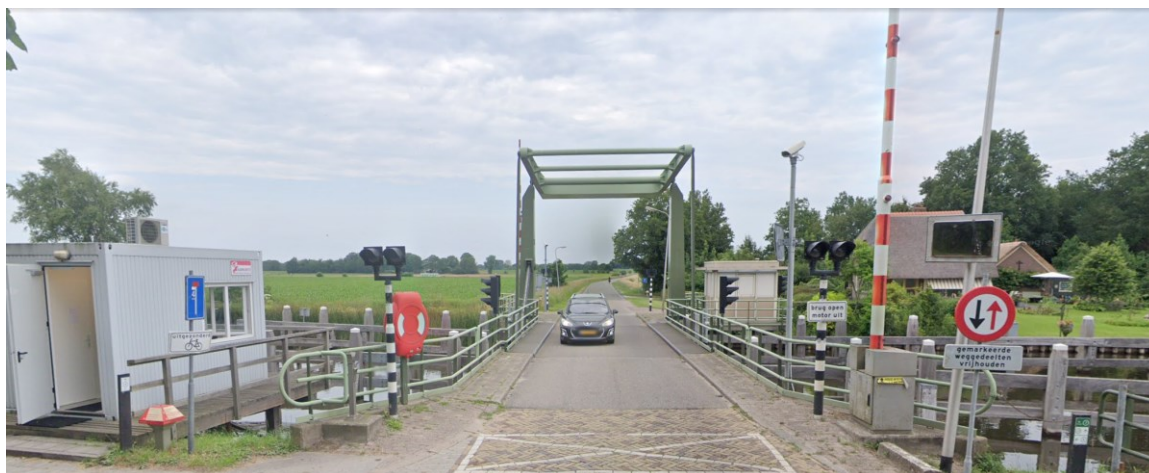
Afbeelding 5.5 Overzichtsfoto Hesselingenbrug (bron: Google Earth)
