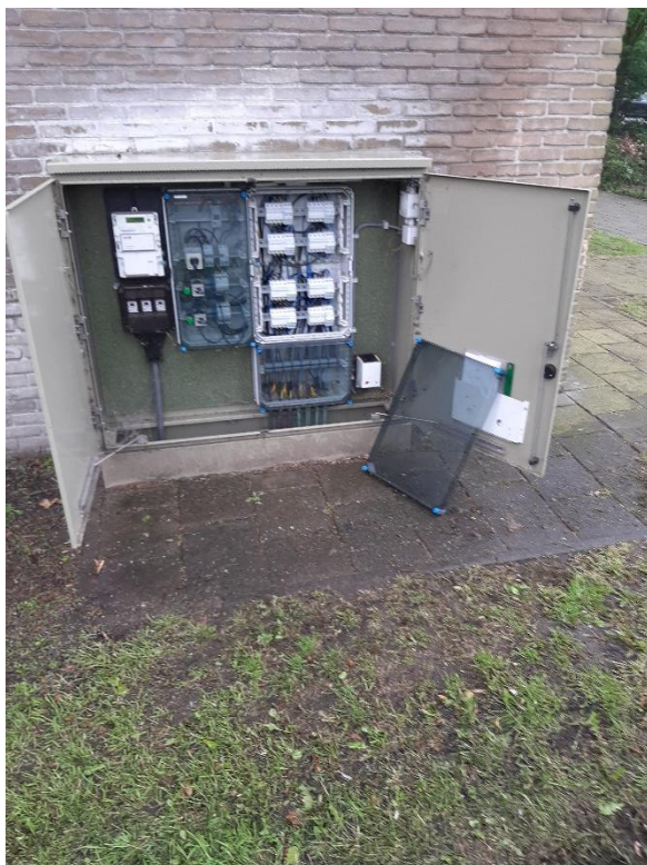
Foto 1: Kast met schakel- en verdeelinrichting
