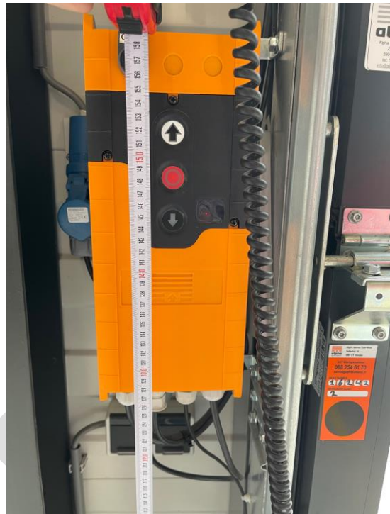
Montage hoogte 1500 mm + vloer (hart bedienknop O)
