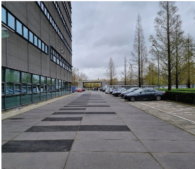
centrale as over het buitenterrein
