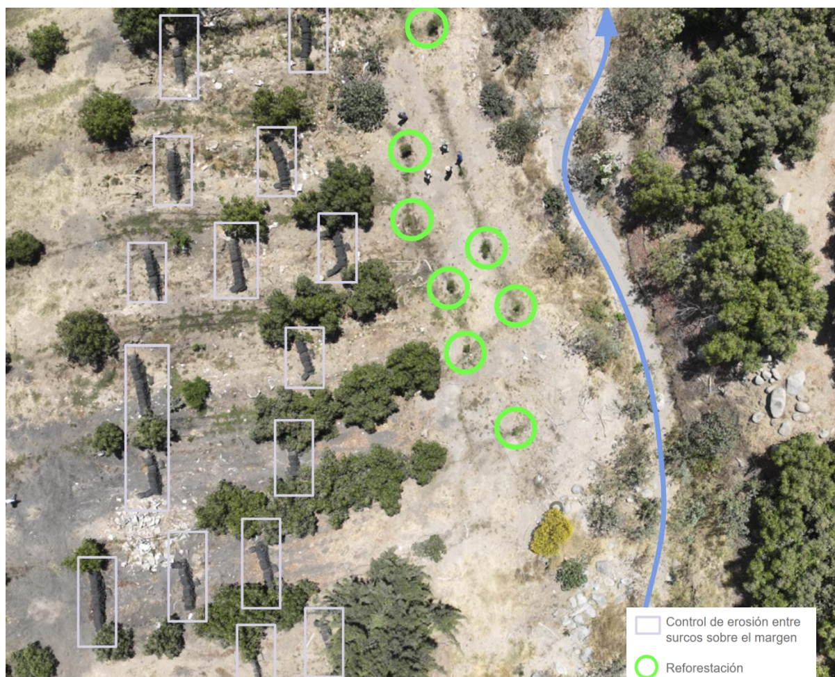
Imagen 23. Obras para el control de erosión en surcos y reforestaciones en cauces.
