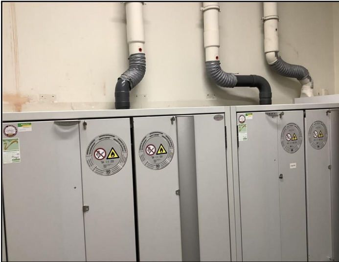
Chemiekasten met afzuiging
