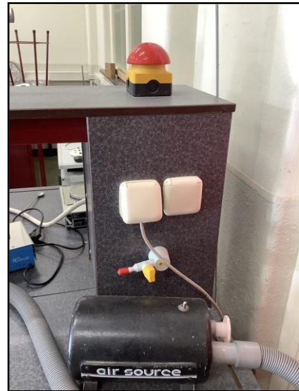
Gasaansluiting met noodknop
