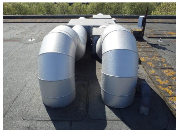
24: aanwezige kanalen met doorvoeren
