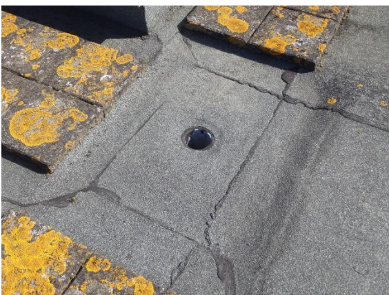
17: verdiepte hemelwaterafvoer
