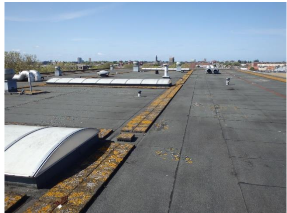
4: overzicht deel grote dakvlak
