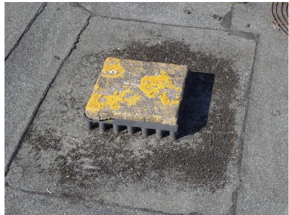
16: hemelwaterafvoer met bladvangtegel
