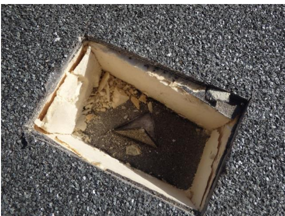
5: insijding 1 dakbedekkingsconstructie
