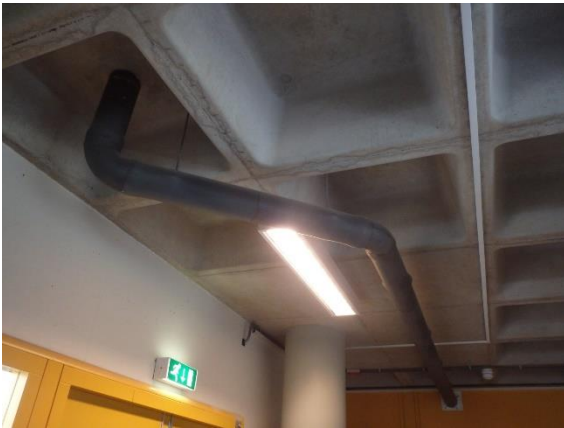
19: aanzicht onderzijde dak met hwa-buis
