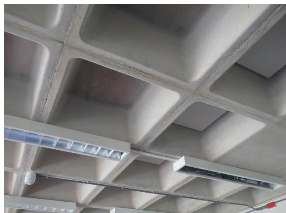
12: aanzicht onderzijde dak, betonnen elementen
