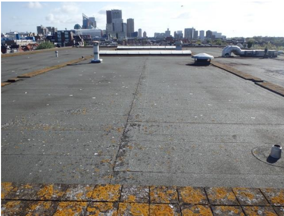
1: overzicht deel grote dakvlak
