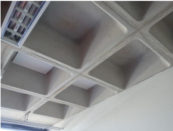
13: aanzicht onderzijde dak, betonnen elementen
