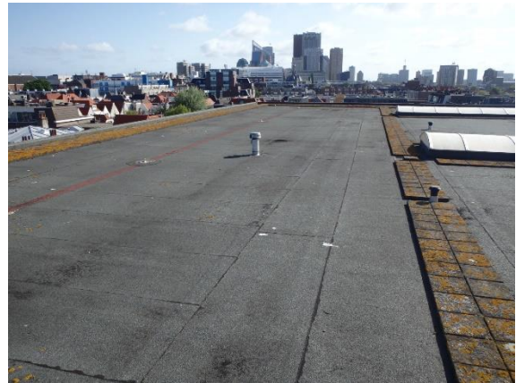
2: overzicht deel grote dakvlak
