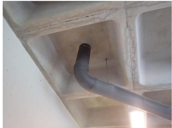
20: aanzicht onderzijde dak met hwa-doorvoer
