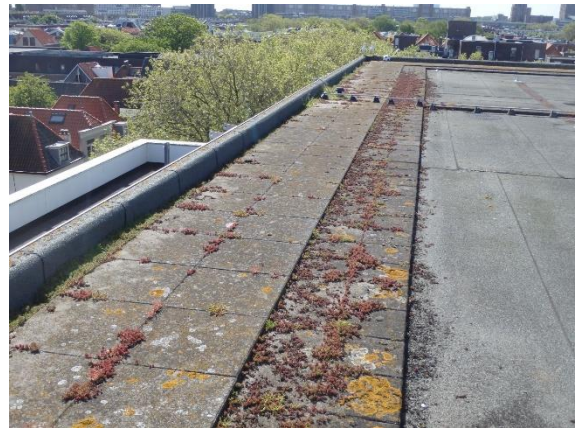
28: aanzicht langs dakrand
