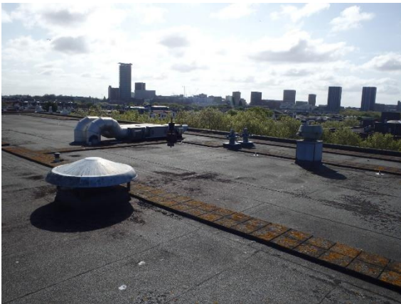
3: overzicht deel grote dakvlak
