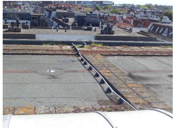
26: aanwezige installatie bliksembeveiliging
