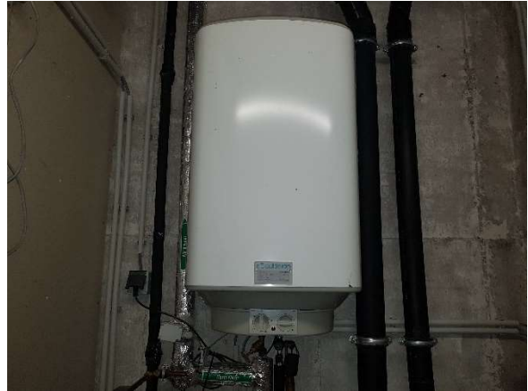
warmtapwaterbereider nr.15
