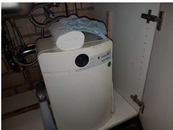
warmtapwaterbereider nr.5
