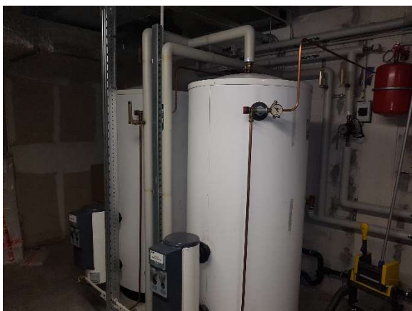
warmtapwaterbereider nr.12
