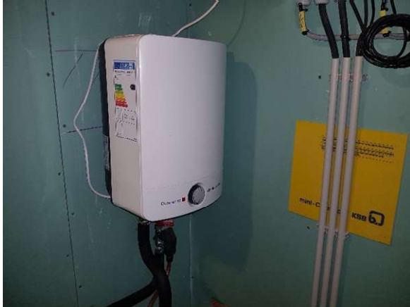
warmtapwaterbereider nr.1
