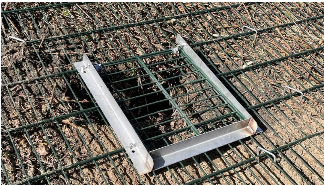
Afbeelding 41. Voorbeeld gaas mét afdekpoot (bron: Stichting Das&Boom).
