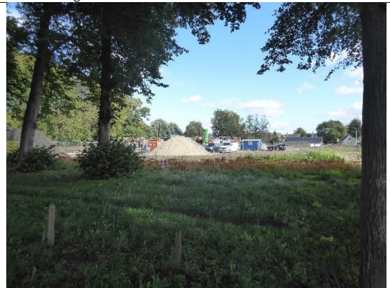
Afbeelding 10. Reeds aangevangen bouwwerkzaamheden in kamer 7.
