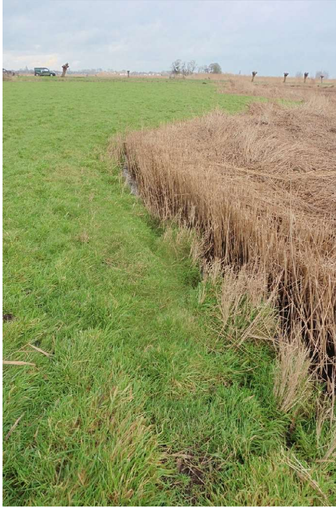
Bestaande greppel, te verbreden tot 1m bodembreedte
