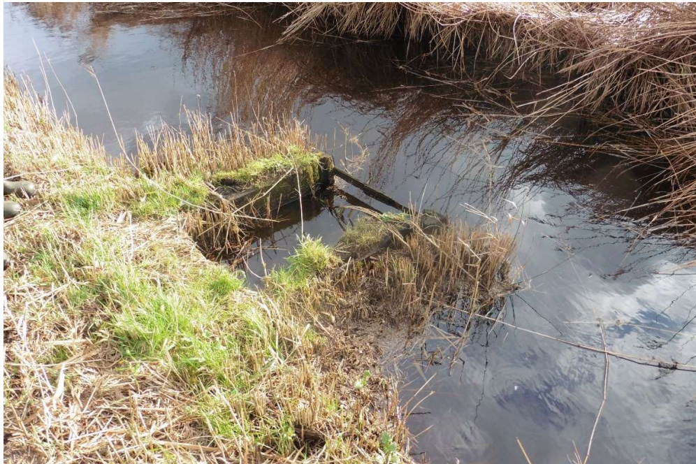
Huidige uitlaat peilvak 2 nabij weg. (te vervangen)
