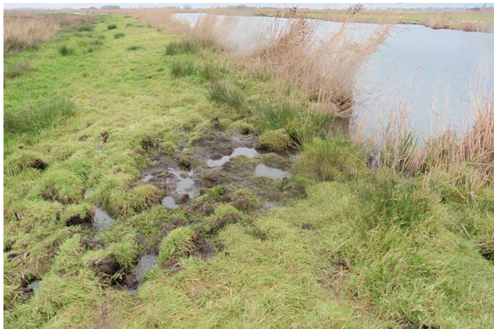
De lokaal herstellen van de kade aan de noordzijde van het perceel.
