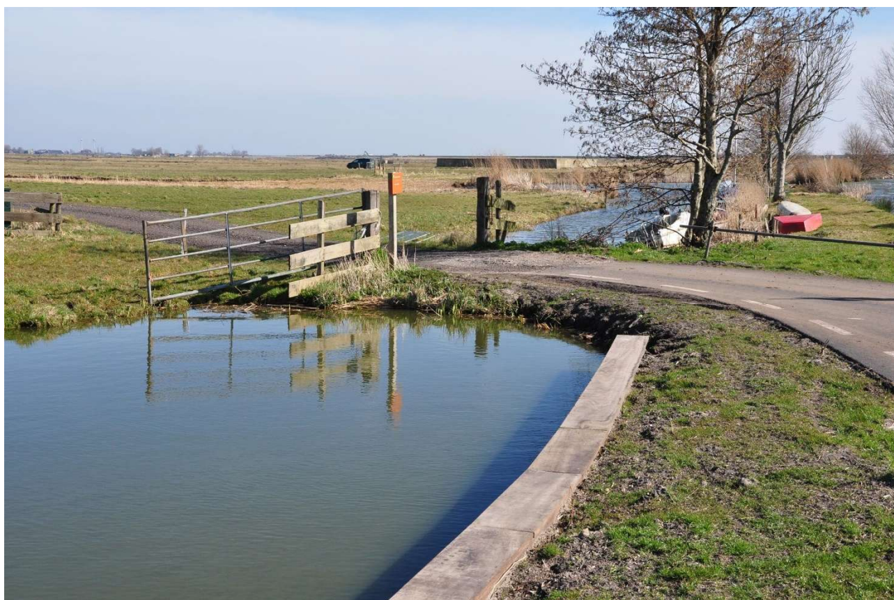
M25, Dam bij hoofdingang (nabij de Kikkert). Te verbreden
