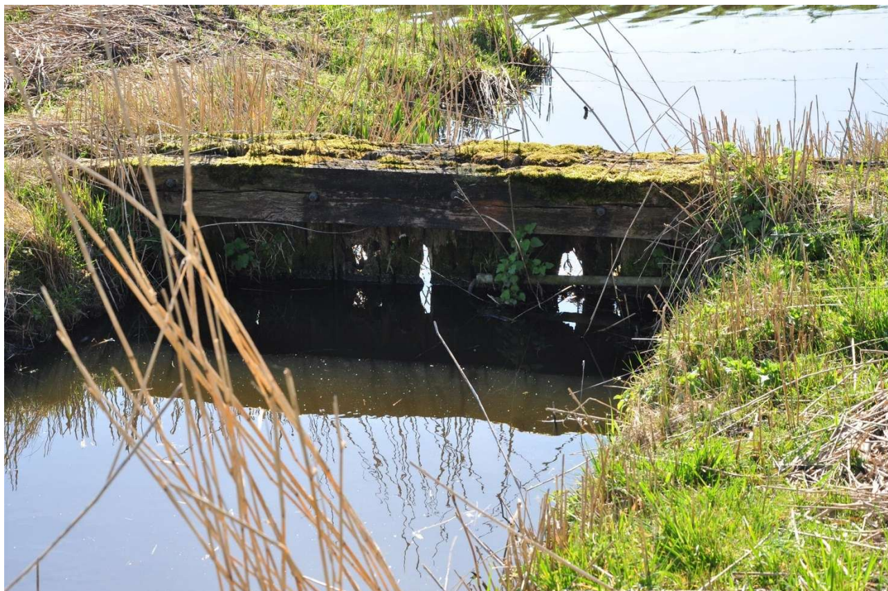
K05, bestaande damwand. Te vervangen door verlengen huidige dam.
