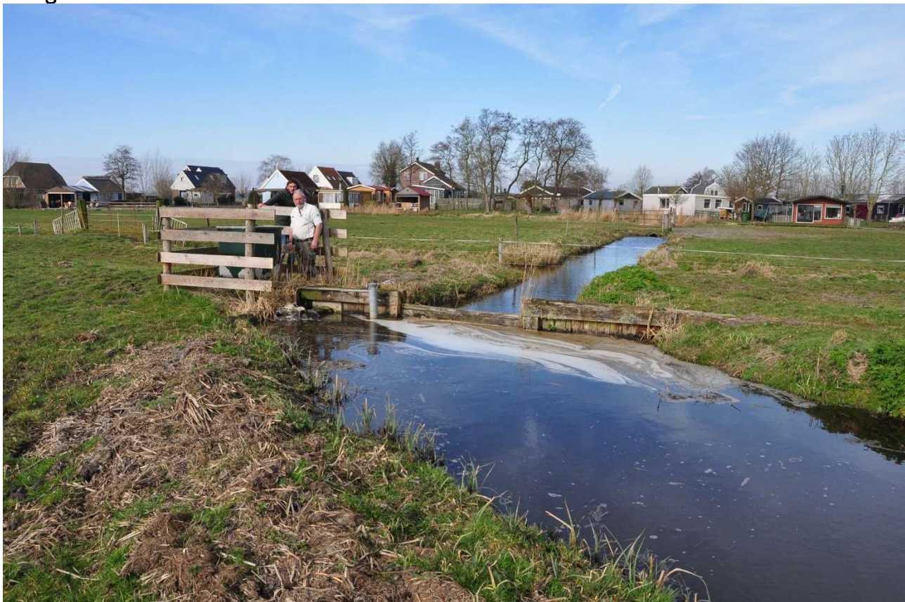
K01, bestaande pomp en damwand. Te vervangen en veranderen
