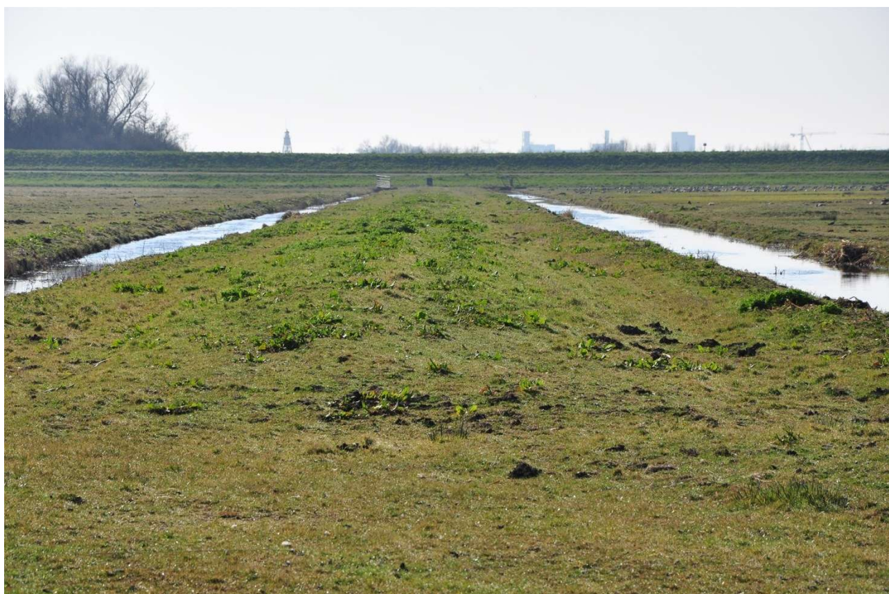
Kade tussen peilvak 2 en 3. Te optimaliseren dwarsprofiel d.m.v. natuurvriendelijke oevers (DP K31)
