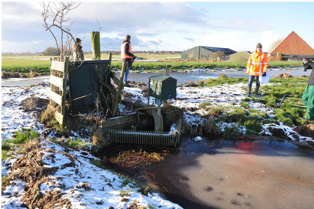
MG3, bestaande uitlaat. Vopopomp vervangen, dam/duiker aanpassen.
