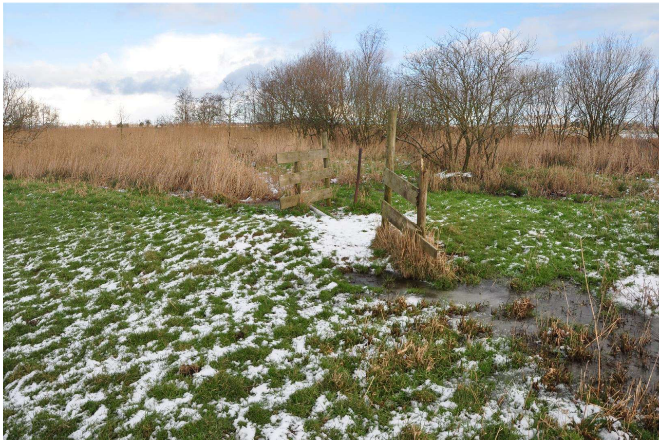
MG-DV1, huidige situatie dam en sloot/ greppel. Herprofiëren/graven greppel, duiker aanbrengen in dam.
