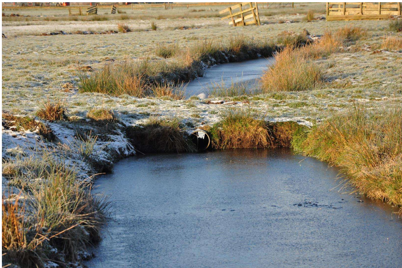
V-DV4, 5, 6 en 7, Niet functionerende dammen met duikers. Aanpassen en functionerend maken.
