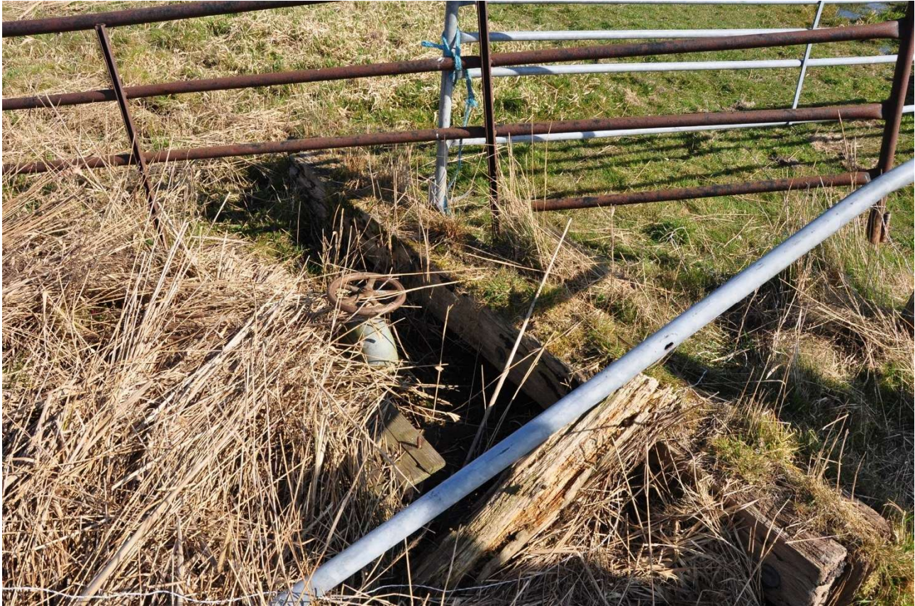
M01, Bestaande afsluitbare duiker, Te vervangen / herstellen
