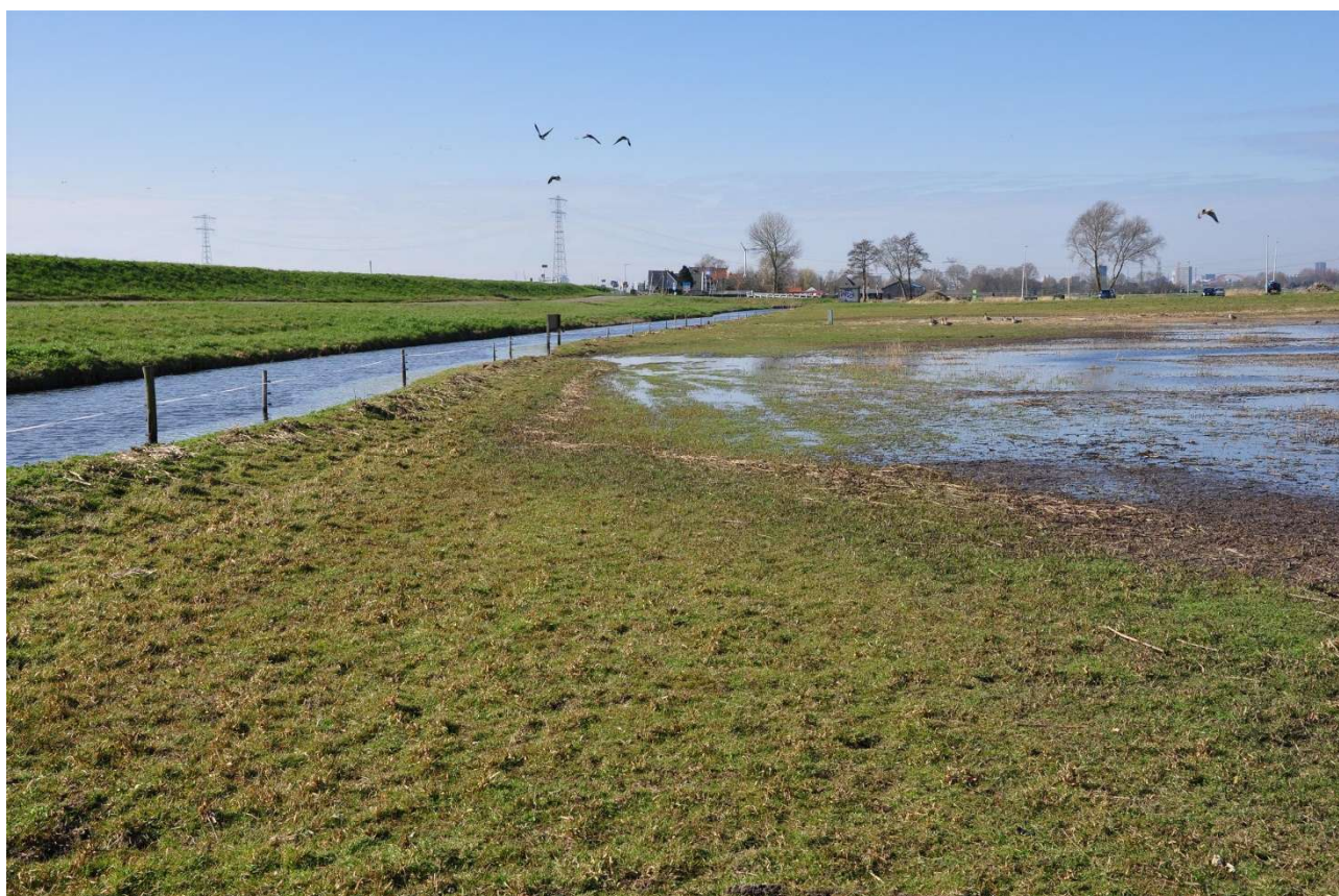
Kade tussen peilvak 1 en polderpeil (langs Markermeerdijk) Te herstellen met grond o.a. van aanleg NVO (DP K21)
