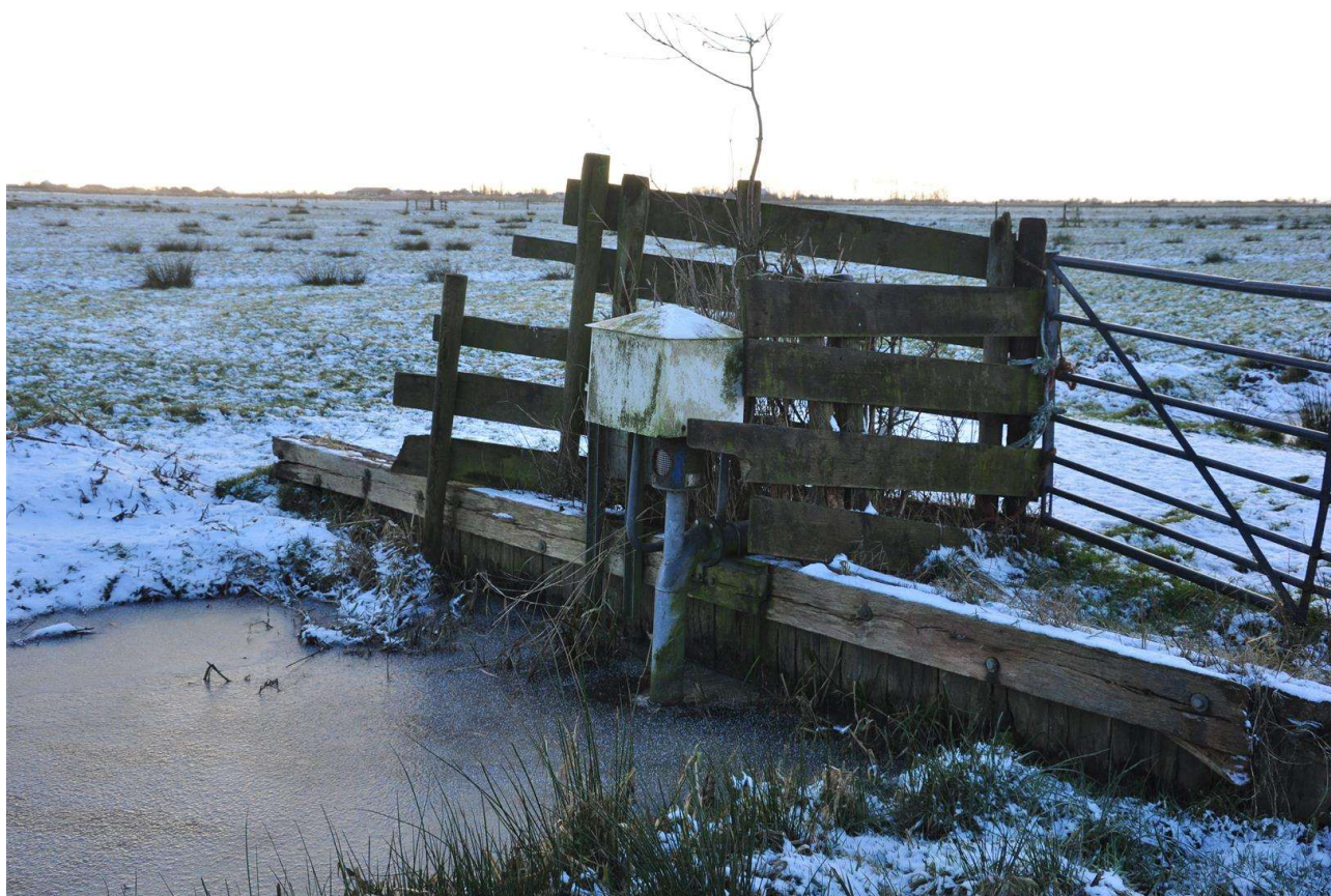
V01, Inlaat met Vopo pomp. Vervangen door fauna pomp
