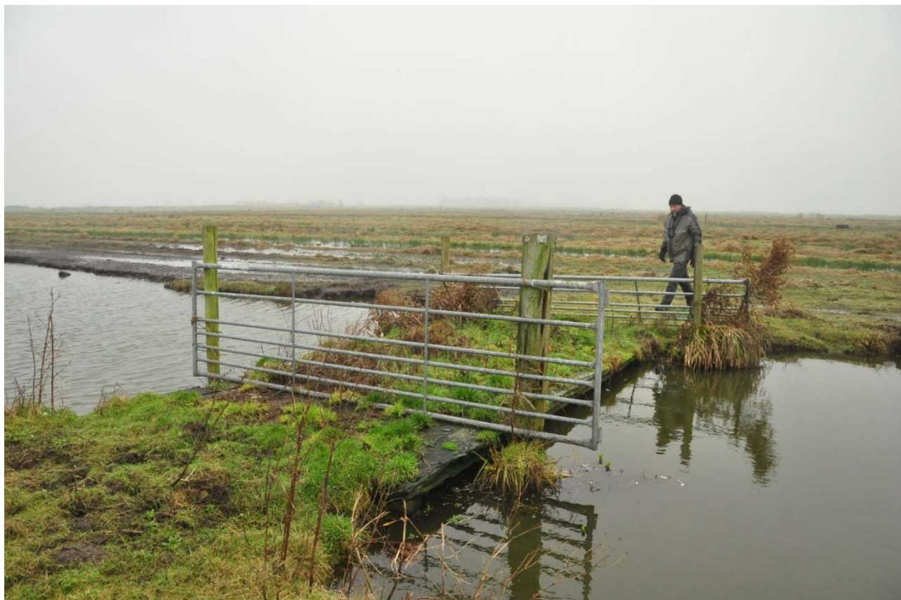
M22c, Brug van draglineschotten over hoofdwatgang. Vernieuwen.
