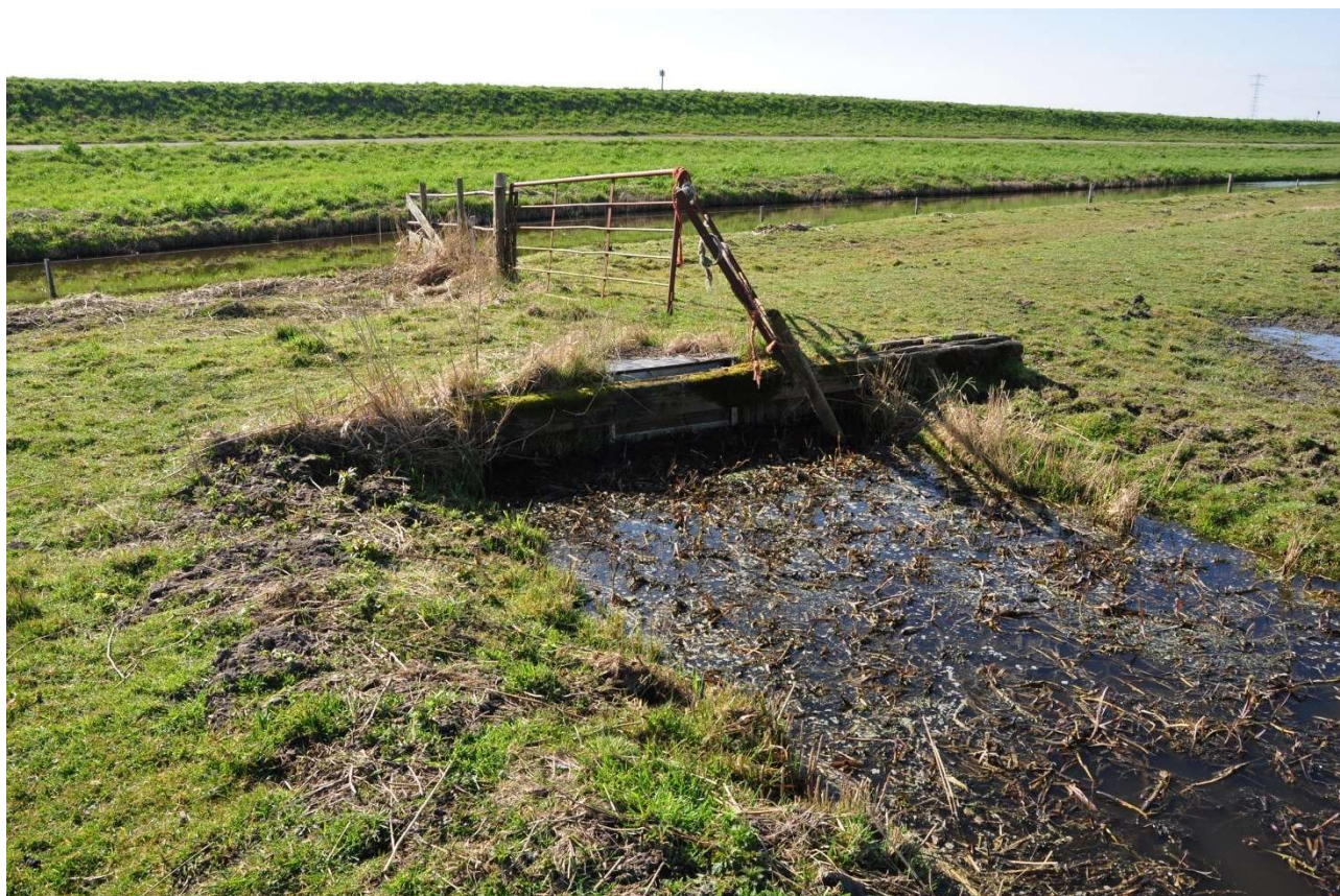
K03, bestaande uitlaat. Te vervangen / renoveren
