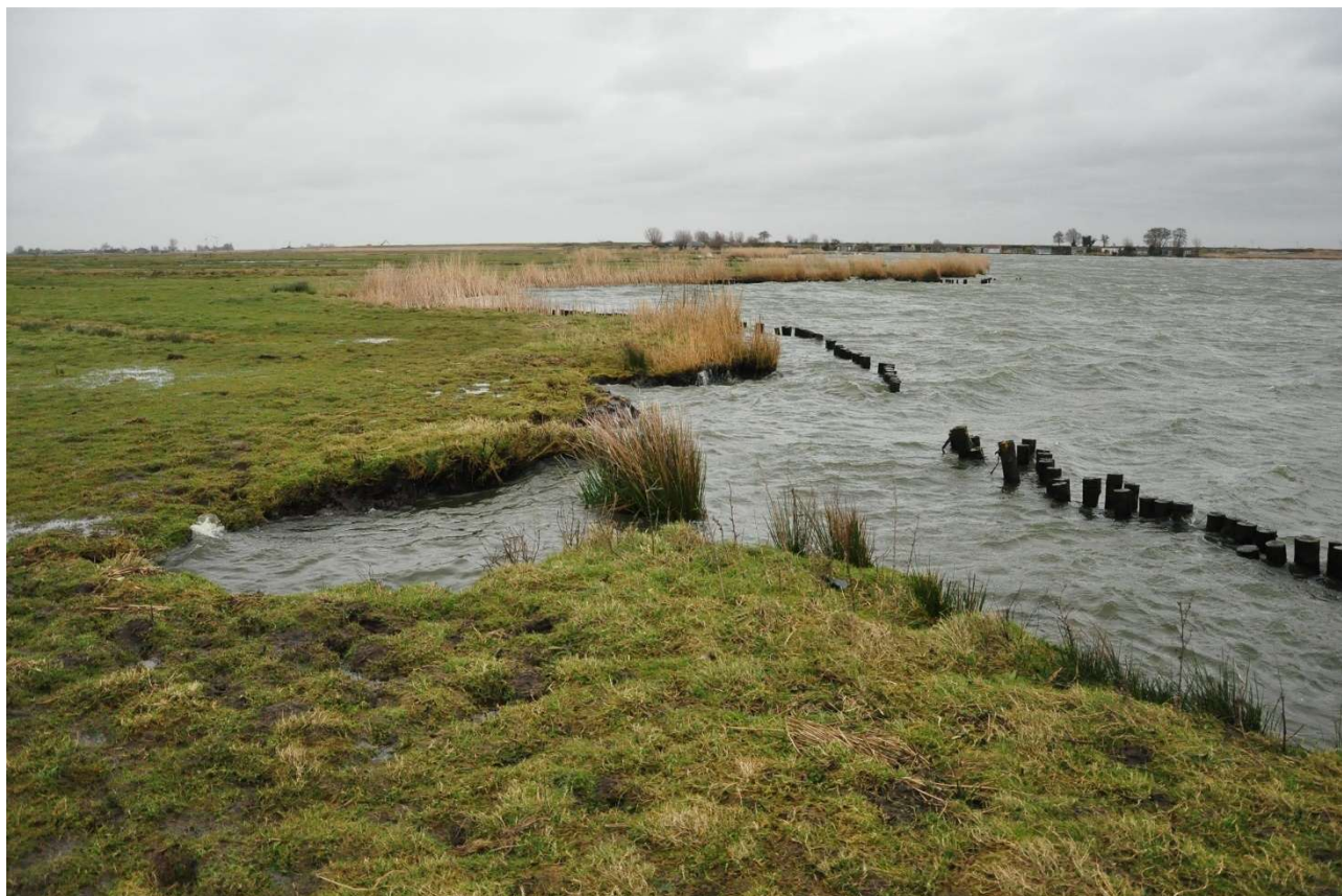
Oever Kinselmeer. Oeverbescherming in het meer realiseren.
