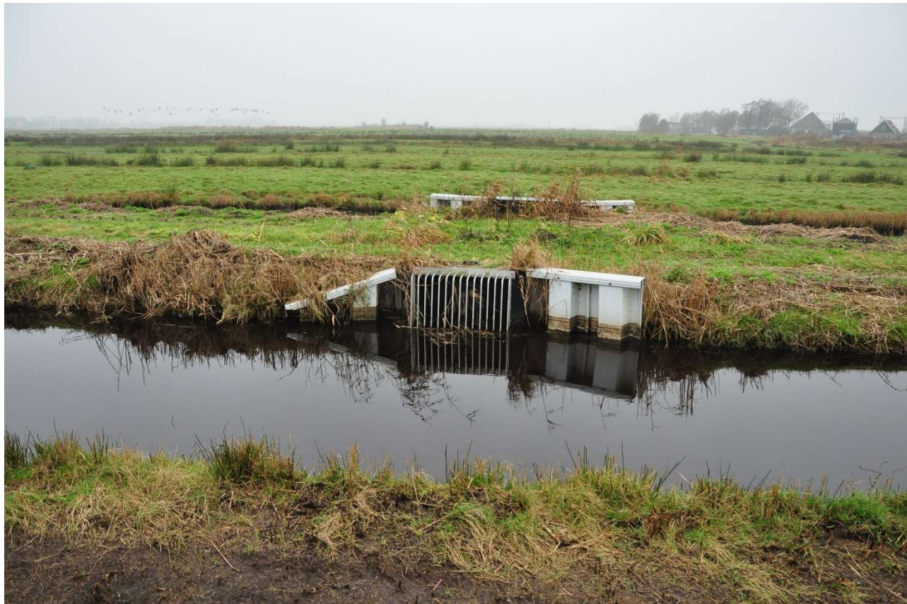
M12, Bestaande vlotterpomp. Vervangen damwand en onderhoud pomp.
