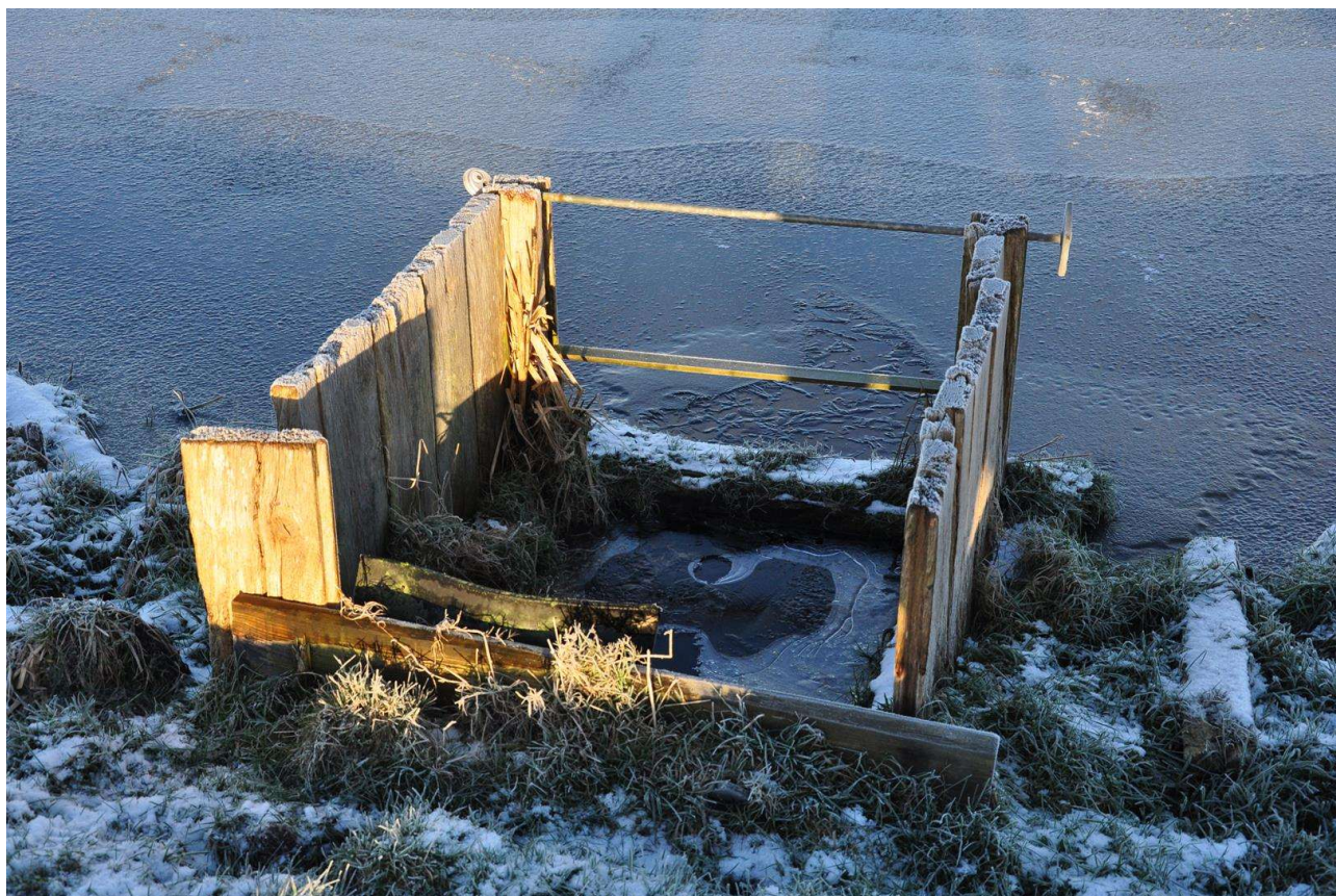
V02; uitlaatwerk. Geheel vervangen
