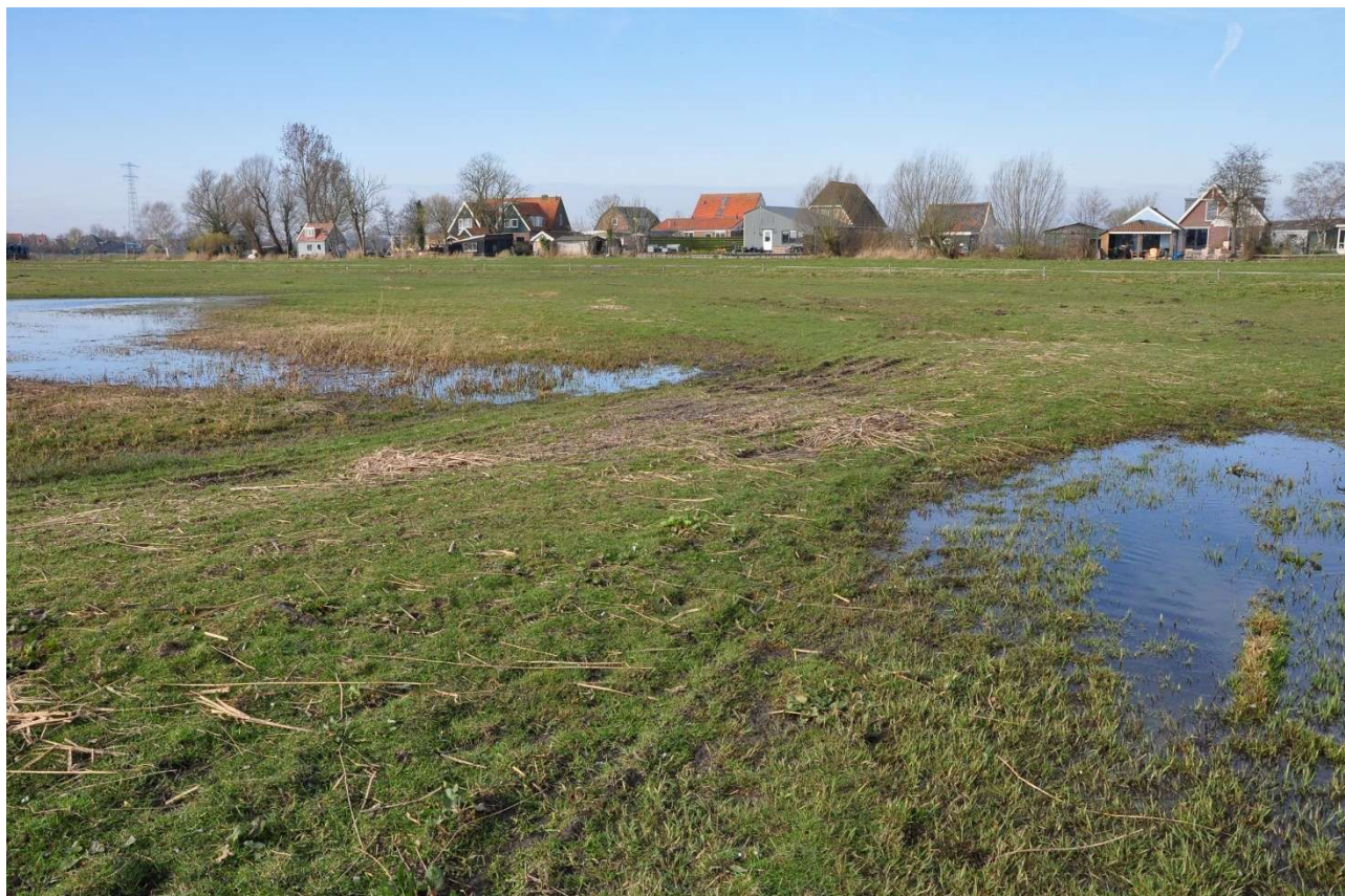
Kade tussen peilvak 1 en 2. Te versterken, incl. verwijderen kopakkerbuizen onder de kade. (DP K25)
