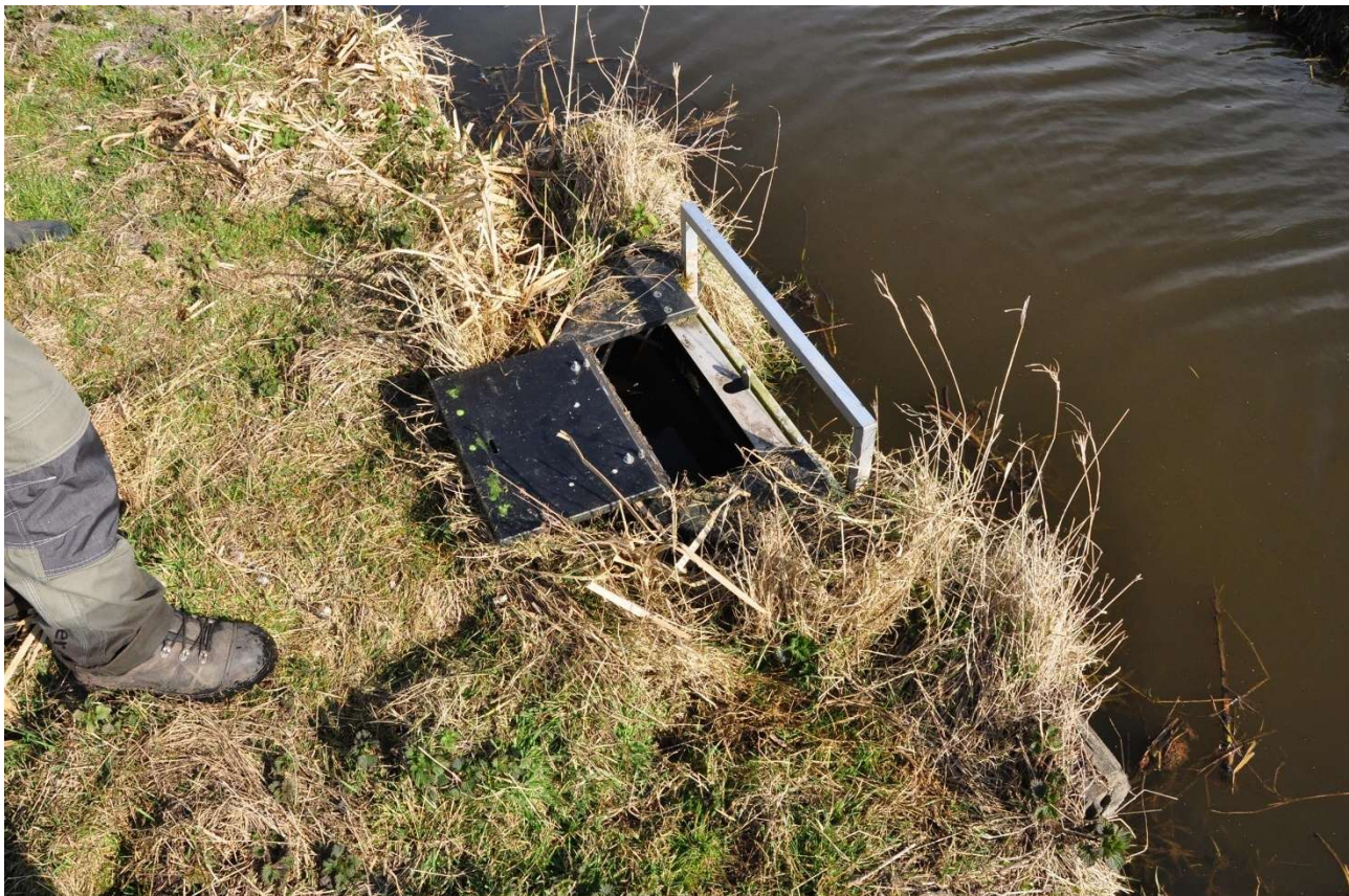
K02, bestaan de stuwpunt (schotbalken) Te vervangen
