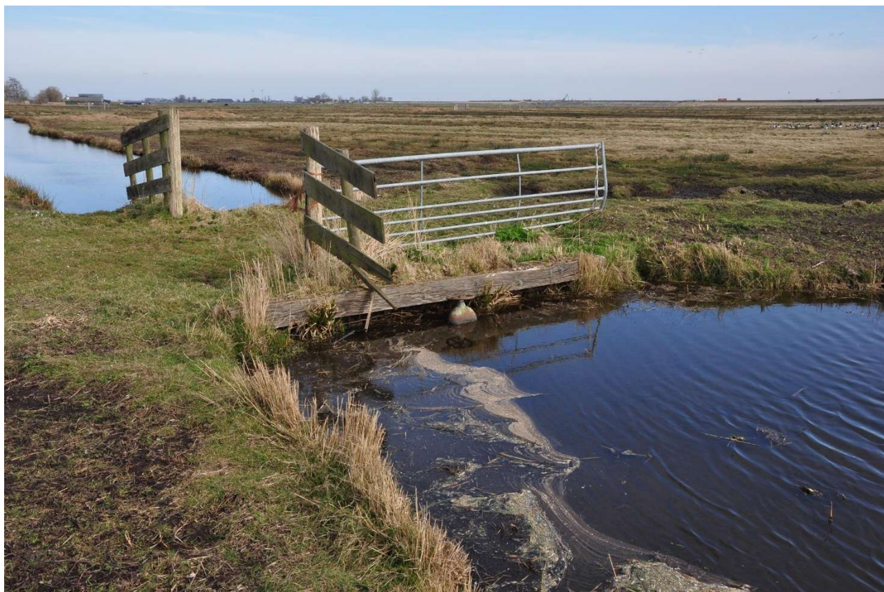
M14, afsluitbare duiker in dam. De duiker verwijderen.
