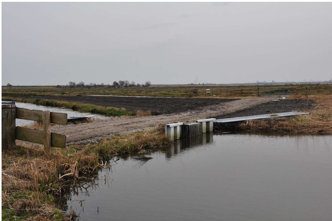
M05, Bestaande VOPO pomp (uitlaat peilvak 2b en 3), te verbeteren incl. onderhoud.
