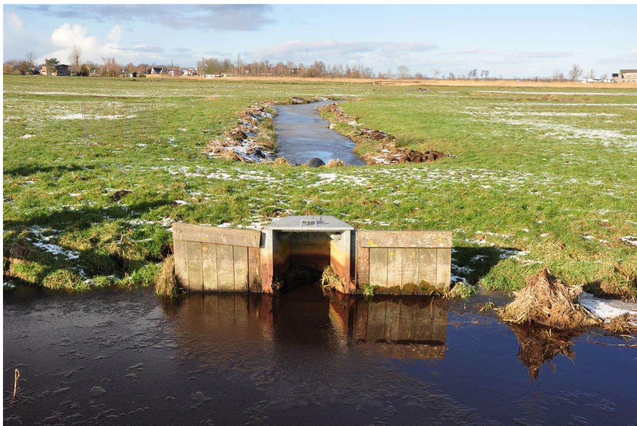
MG02, Bestaande overstort tussen peilvak 1 en 2. Vervangen en vernieuwen
