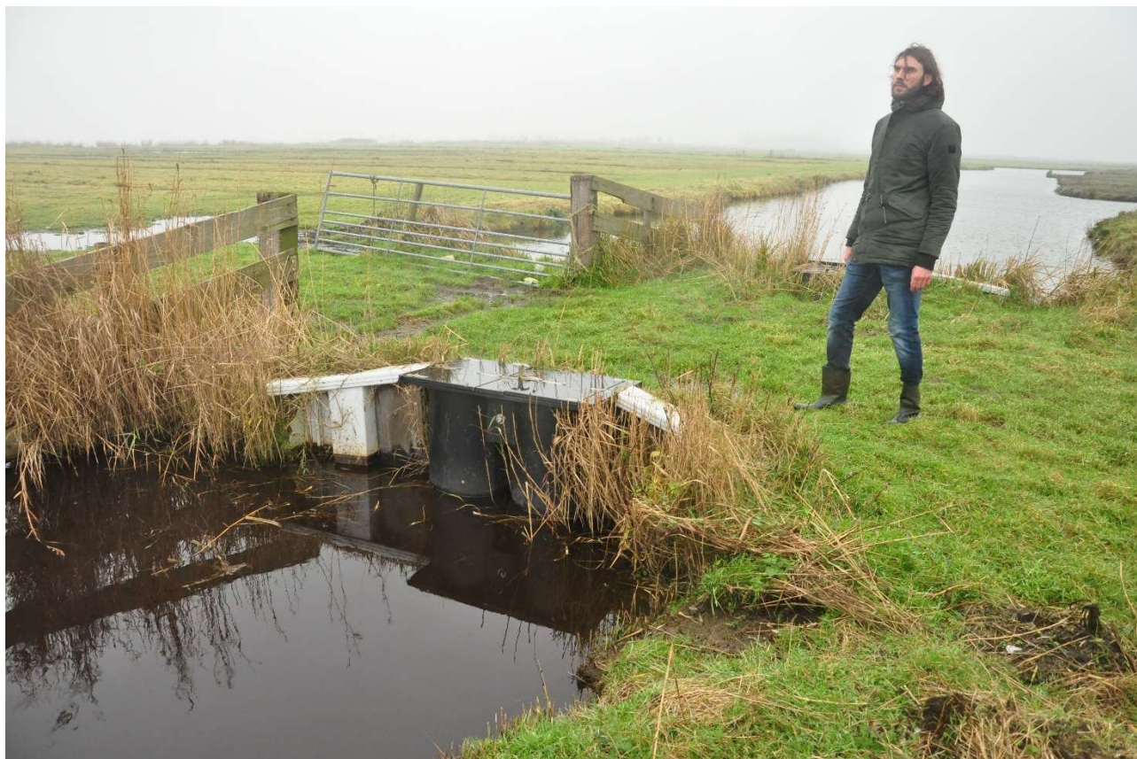
M15, Dam met Vlotterinlaat. Te veranderen.
