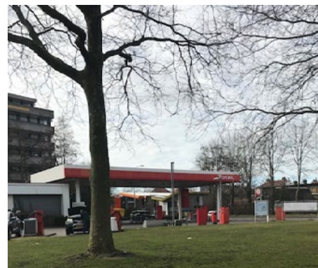
1. Voormalig Total pompstation, gesloopt in 2023'.
