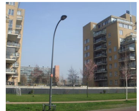
4. Appartementencomplex Nieuw park Leeuwensteijn
