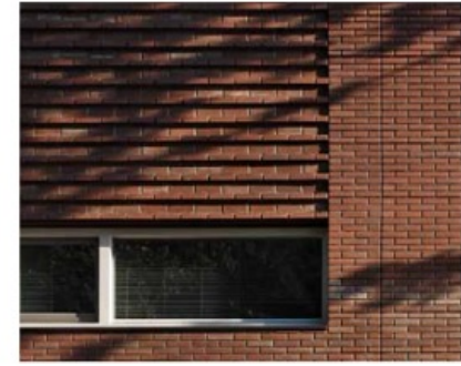
dieptewerking van gevel door genuanceerd metselwerk
