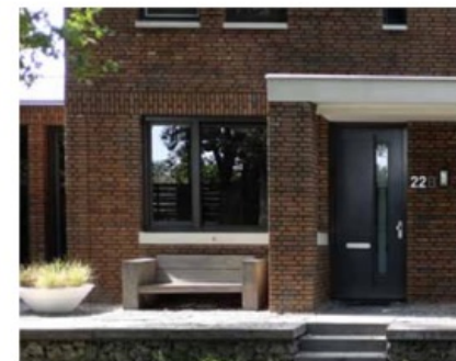
kader van bijzonder metselwerk
