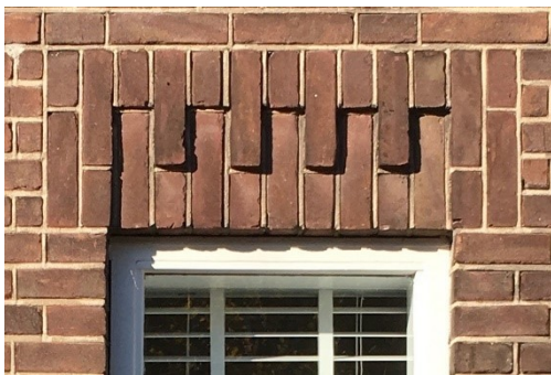
Detail in metselwerk – vakmanschap
