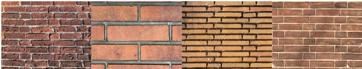
Detail in metselwerk – kleur- en maatnuances in baksteen en verschil in voeg
