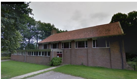
Gemetselde schoorsteen en rode pannen op de gymzaal
