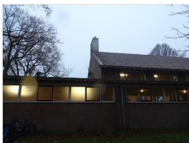
Figuur 2.6 Bijgebouw met gymzaal aan de noordzijde.
