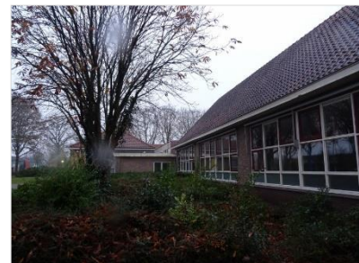
Figuur 2.5 Schoolgebouw vanaf de zuidzijde .
