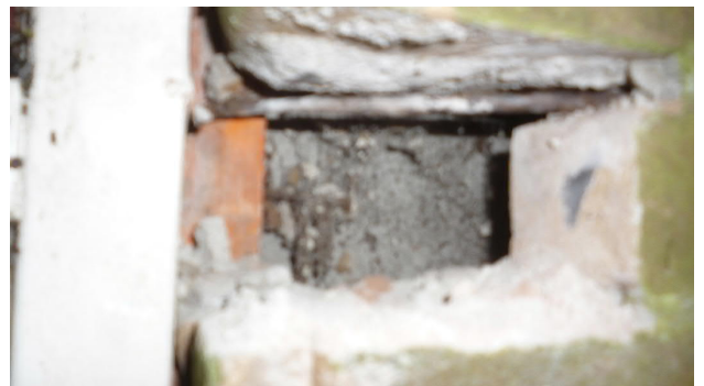
Foto 8: Controle van de spouw in Bouwdeel '60, géén verdachte materialen aangetroffen..
