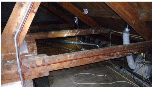
Foto 19: De verschillende zolderingen zijn geïnspecteerd, geen asbesthoudende zaken.
