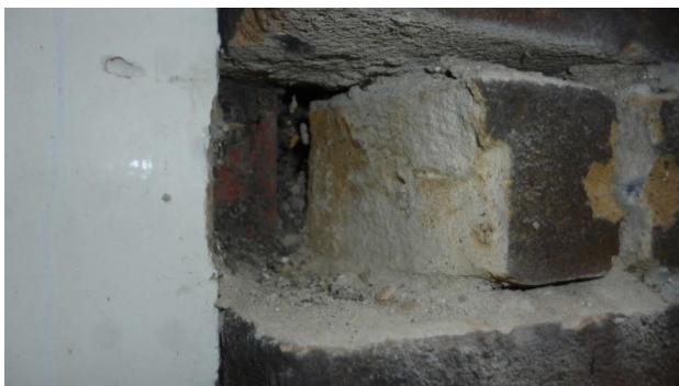
Foto 11: Controle van de spouw in Bouwdeel '30, géén verdachte materialen aangetroffen..
