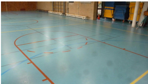
Foto 21: De vloer met onderliggende lagen van de gymzaal, kon vanwege het gebruik niet worden geïnspecteerd.
