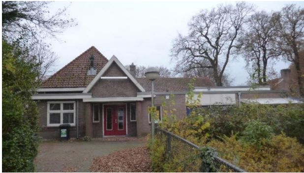
Foto 1: Vooraanzicht van het schoolgebouw (oude hoofdentree), met links bouwdeel 1930 en rechts 1960/1994
