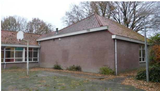
Foto 5: Aanzicht van de Nieuwbouw uit 1994.
