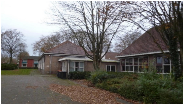
Foto 3: Zijaanzicht schoolgebouw met de overgang van Bouwdeel '30 (rechts) naar Bouwdeel '57.
