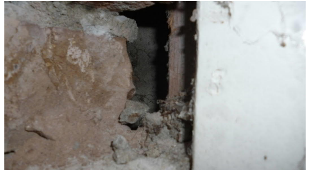
Foto 10: Controle van de spouw in Bouwdeel '30, géén verdachte materialen aangetroffen..
