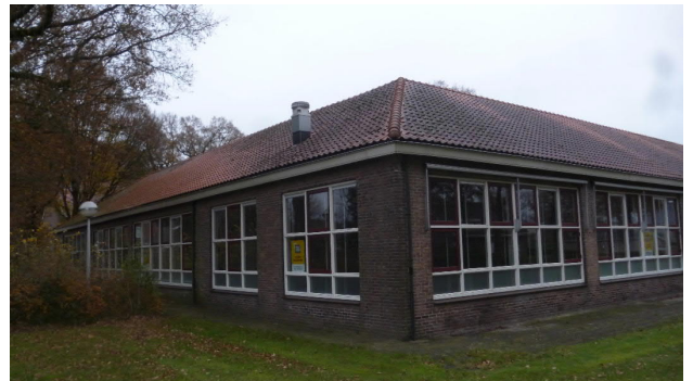
Foto 4: Achteraanzicht met de overgang van Bouwdeel '60 naar '94 (t.h.v. lantaarmpaal)
