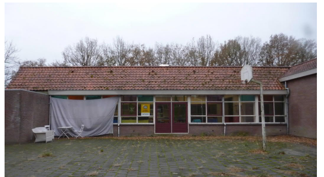
Foto 6: Aanzicht van de Nieuwbouw uit 1994.
