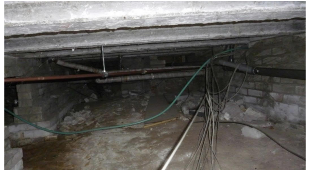
Foto 18: De verschillende kruipruimten zijn geïnspecteerd, geen verdachte zaken.
