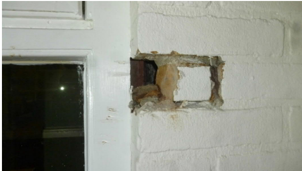
Foto 9: Controle van de spouw in Bouwdeel '57, géén verdachte materialen aangetroffen..
