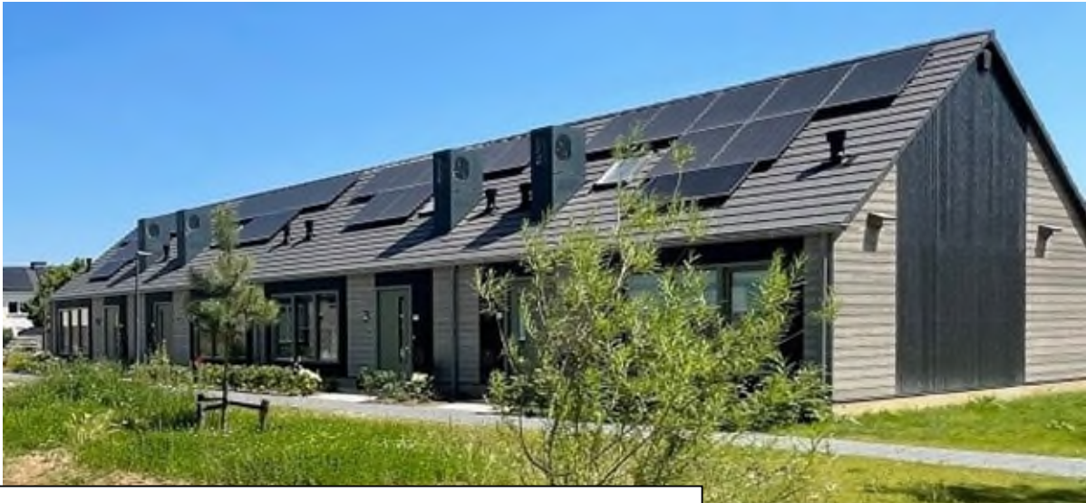
Inspiratie: Sociale huurwoningen Wonion Silvolde. Houten gevels en natuurlijke isolatiematerialen (bron: Gelderland.nl)
