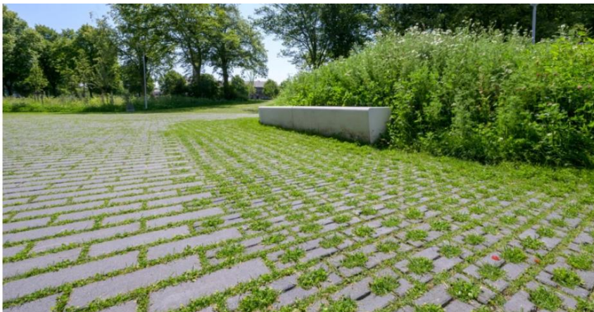
Figuur 6 Voorbeeld grasbetonklinker NCB en 40x40x12 cm
