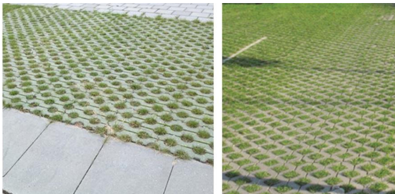
Figuur 5 Voorbeeld grasbetontegel 40x60x12 cm
