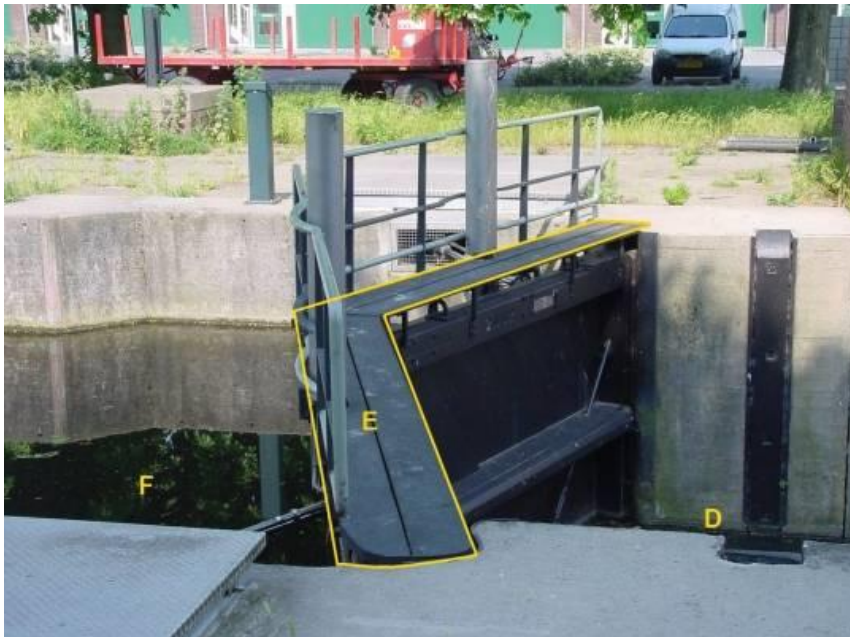
Kunstwerkdeel sluisdeuren van een sluisencomplex
