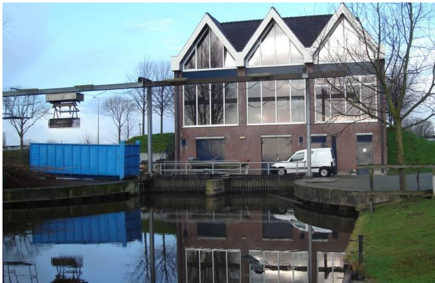
Gemaalcomplex met een pand, onbegroeid en begroeid terreindelen, scheidingen. Bij de instroomopeningen bevinden zich krooshekken.
