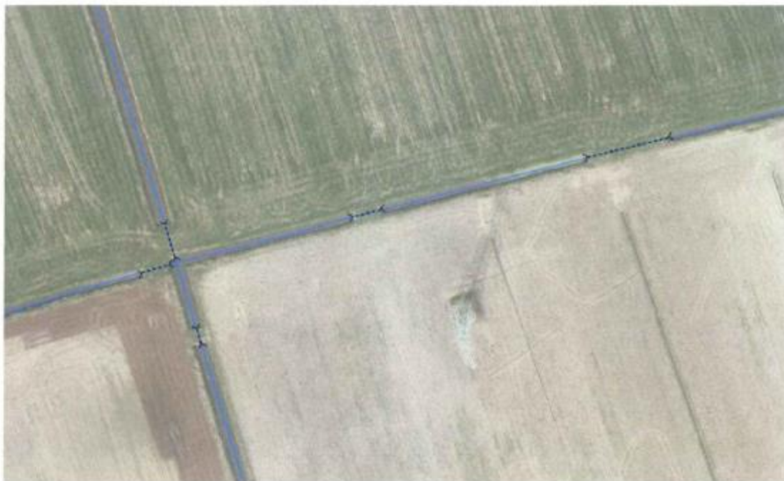
Afbeelding 6 - Waterlopen, onderbroken door dammen met duikers.
