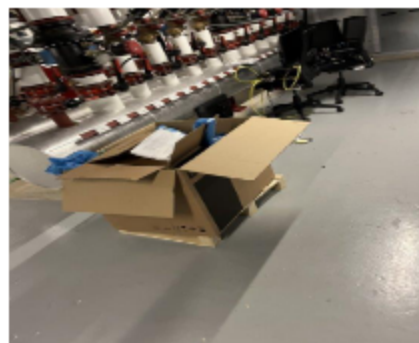
Opslag technische ruimte - overig
