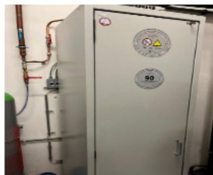
Gassenberging bij lab
