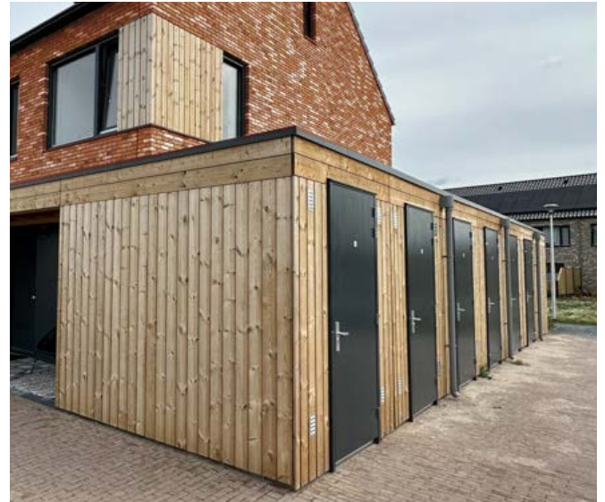
Afb. 2.81 - bergingen aan de zijkant
