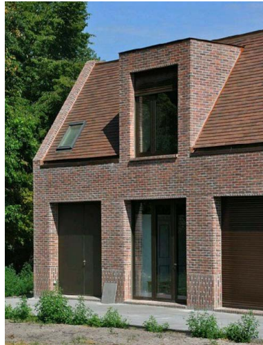
Afb. 3.15 - diepe negge en donkere kozijnen
