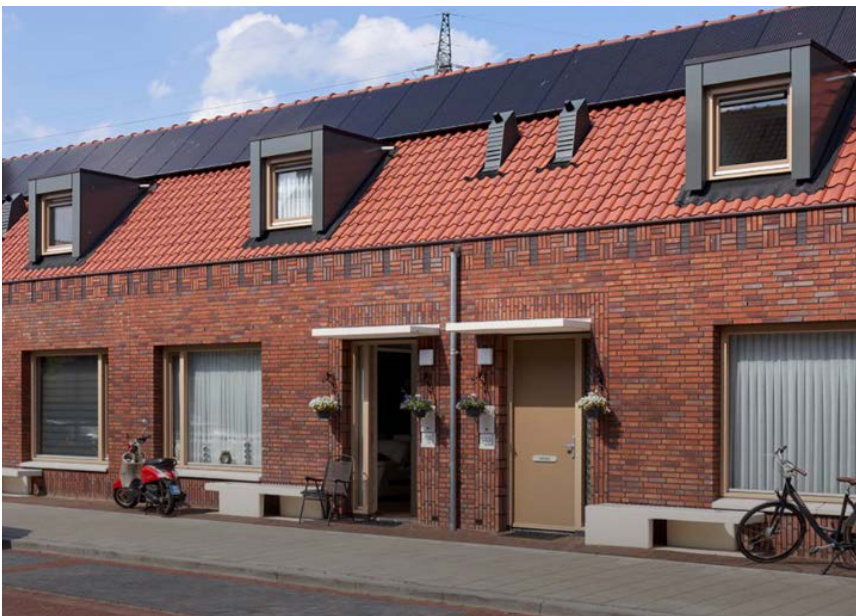
Afb. 3.24 - zadeldak langskap, sociale woningbouw
