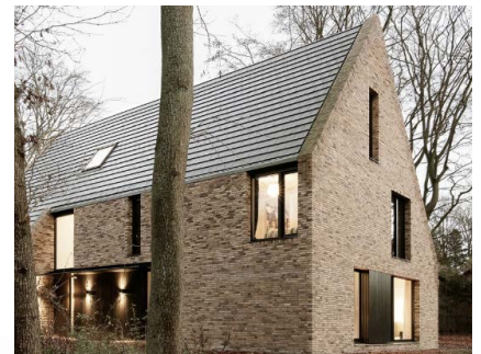
Afb. 2.22 - geleding met grote vlakken en diepe negge
