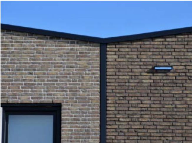
Afb. 2.90 - hemelwaterafvoer in de gevel geïntegreerd
