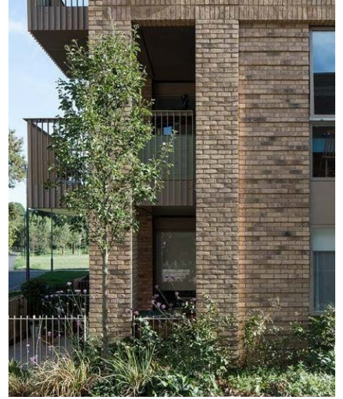
Afb. 3.43 - balkons aan zij- of achterkant
