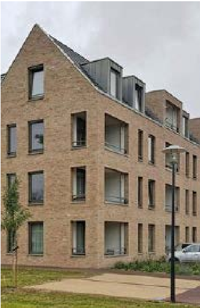
Afb. 3.45 - inpandige balkons en duidelijk afwijkende bovenste etage
