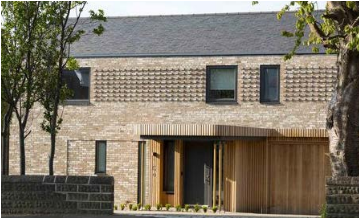
Afb. 2.42 - metselwerk in combinatie met hout
