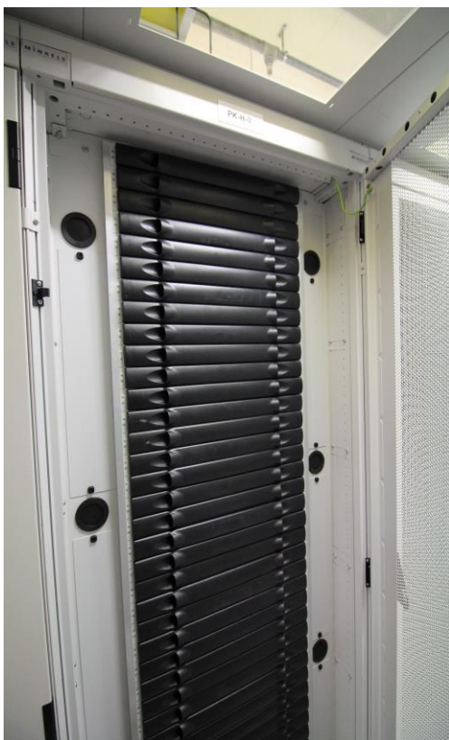
Blindpanelen ter voorkoming van luchtlekkage
