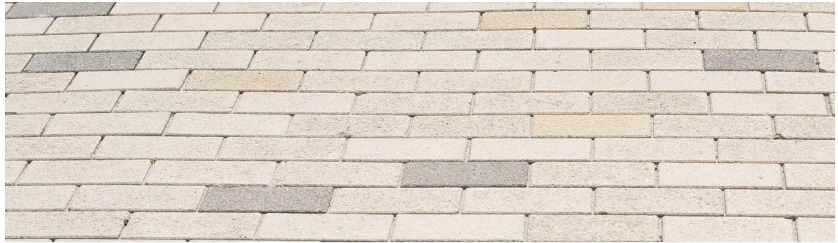
Betontegels op de boulevard.
