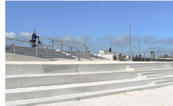
Huidige toegang vanaf de boulevard naar het strand.
