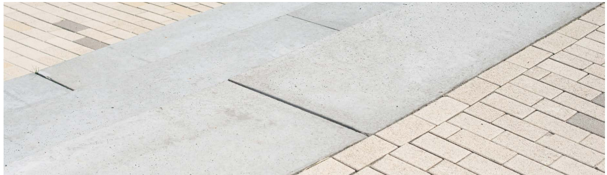
Overloop betontegels naar betontrappen.
