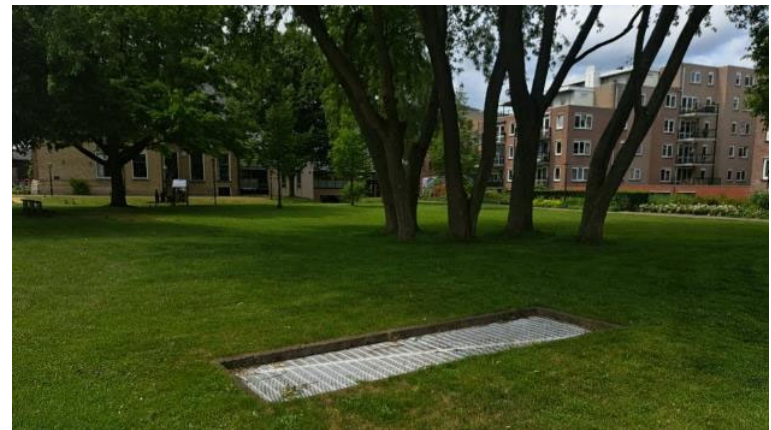
24 Installaties zijn niet dominant aanwezig in het straatbeeld. Deze gaan op in de inrichting van het maaiveld.
