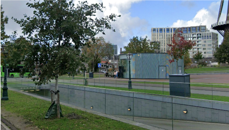
21 De ingang van de parkeergarage aan de Lammermarkt in Leiden is mede door de transparante balustrade ondergeschikt aan het maaiveldontwerp.
